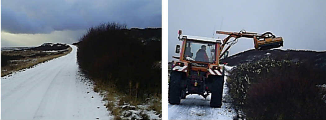
Mynd 36. Kantsláttuvél notuð til að kurla trjágróður sem var farinn að þrengja að vegi. Nóvember 2006.
