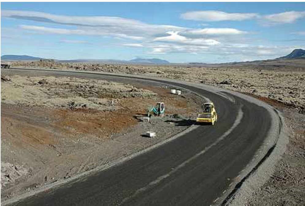
Mynd 34. Tenging af Þrengslavegi upp á Hringveg í byggingu.
