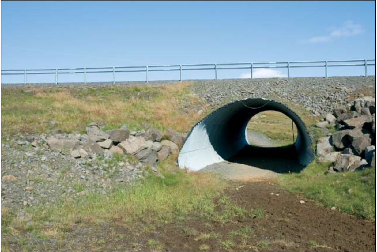
Hringvegur (1) í Rangárvallasýslu, skammt austan Þjórsár. Undingöng fyrir hross.
