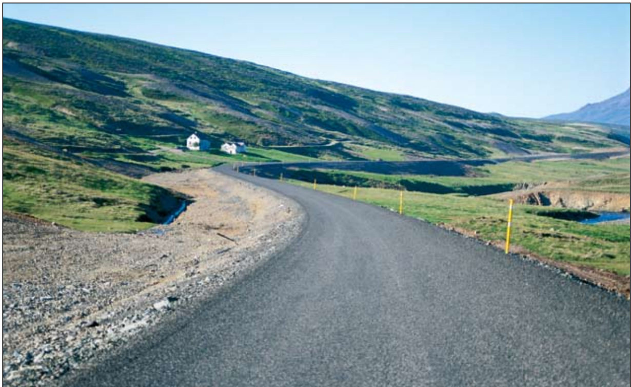
Pverárfjallsvegur (774) sumarið 2003. Nýtt bundið slitlag en uppgræðslu vegfláa ólokið.
