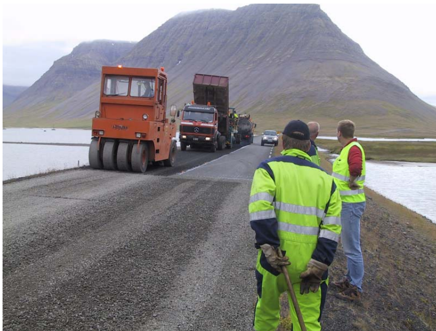
Útlögn á óflokkuðu efni í Öfundarfirði við Vaðal. Á þessari mynd sjást öll tækin að vinni, fremstur er bindiefnisdreifarinn, þá steinefnadreifarin, malarflutningabíllinn og loks valtinn að vinna á kaflaskilum á vinstri akrein.
