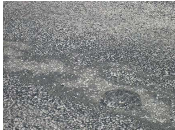
Mynd 4 Nærmynd af skemmd, þar sem í ljós kemur viðgerð á skemmd í undirliggjandi slitlagi.
