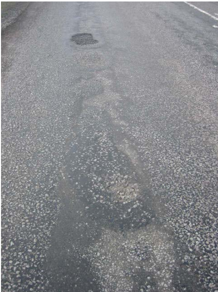
Mynd 3 Ytra hjólfarið sjávarmegin var verst farið og dæmist alveg ónýtt eins og sjá má á myndinni.
