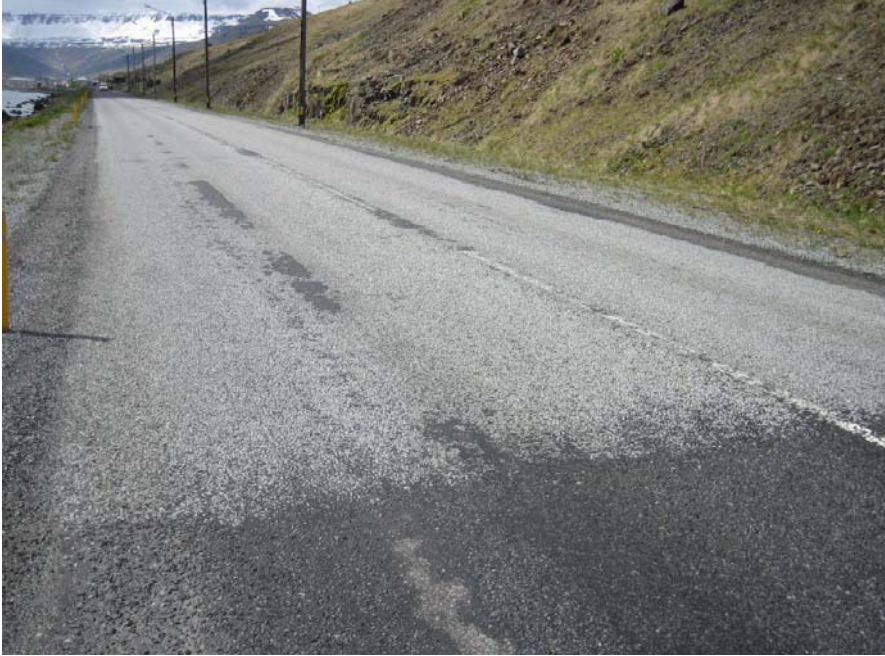
Mynd 11 Yfirlitsmynd af kafla 4 Durasplitt 11/16 mm í júní 2006.
