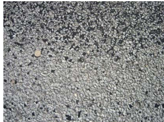
Mynd 14 Yfirlitsmynd af kafla 5 Durasplitt 8/11 mm í júní 2006.
