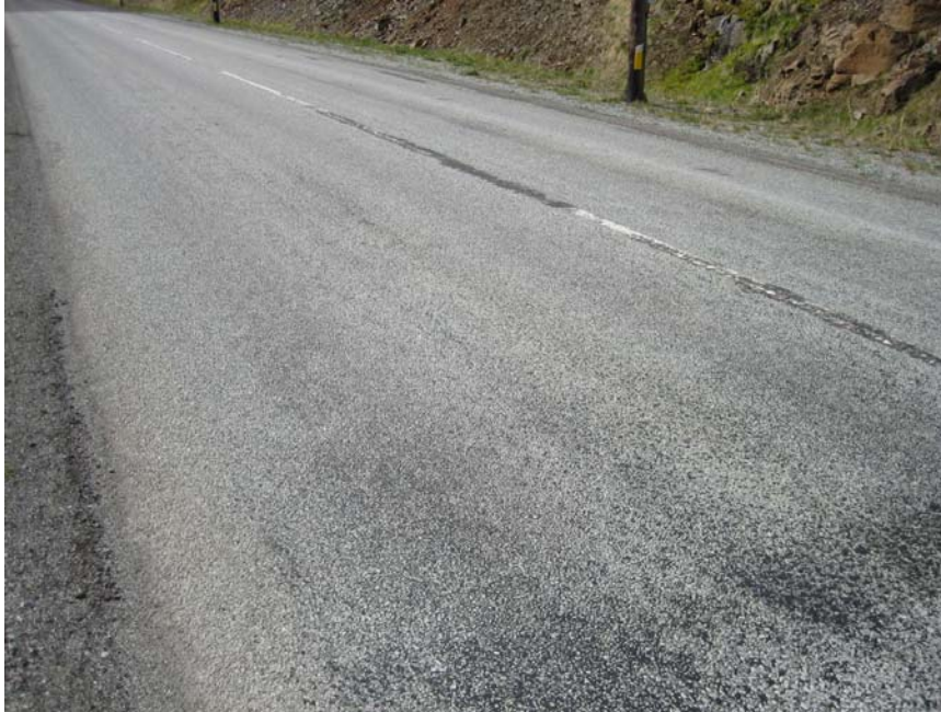
Mynd 14 Yfirlitsmynd af kafla 5 Durasplitt 8/11 mm í júní 2006.
