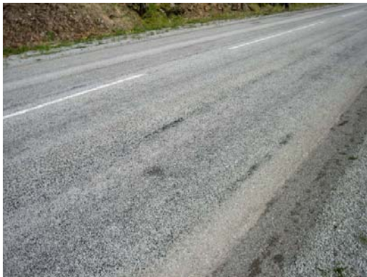
Mynd 14 Yfirlitsmynd af kafla 5 Durasplitt 8/11 mm í júní 2006.
