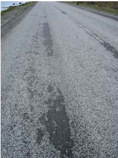
Mynd 11 Yfirlitsmynd af kafla 4 Durasplitt 11/16 mm í júní 2006.
