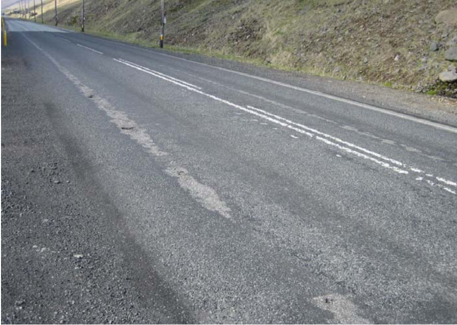
Mynd 8 Yfirlitsmynd af kafla 3 Kleifabjörgum 11/16 mm í júní 2006.
