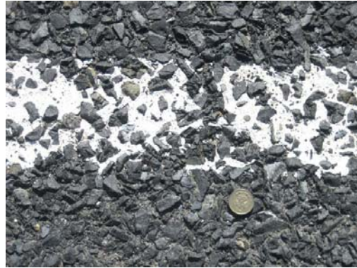
Mynd 8 Yfirlitsmynd af kafla 3 Kleifabjörgum 11/16 mm í júní 2006.
