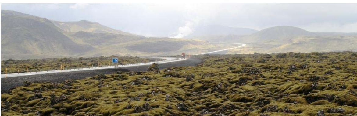
Mynd 4-24 Nýr vegur í Svínahrauni er lagður á landið en ekki ýtt upp.
