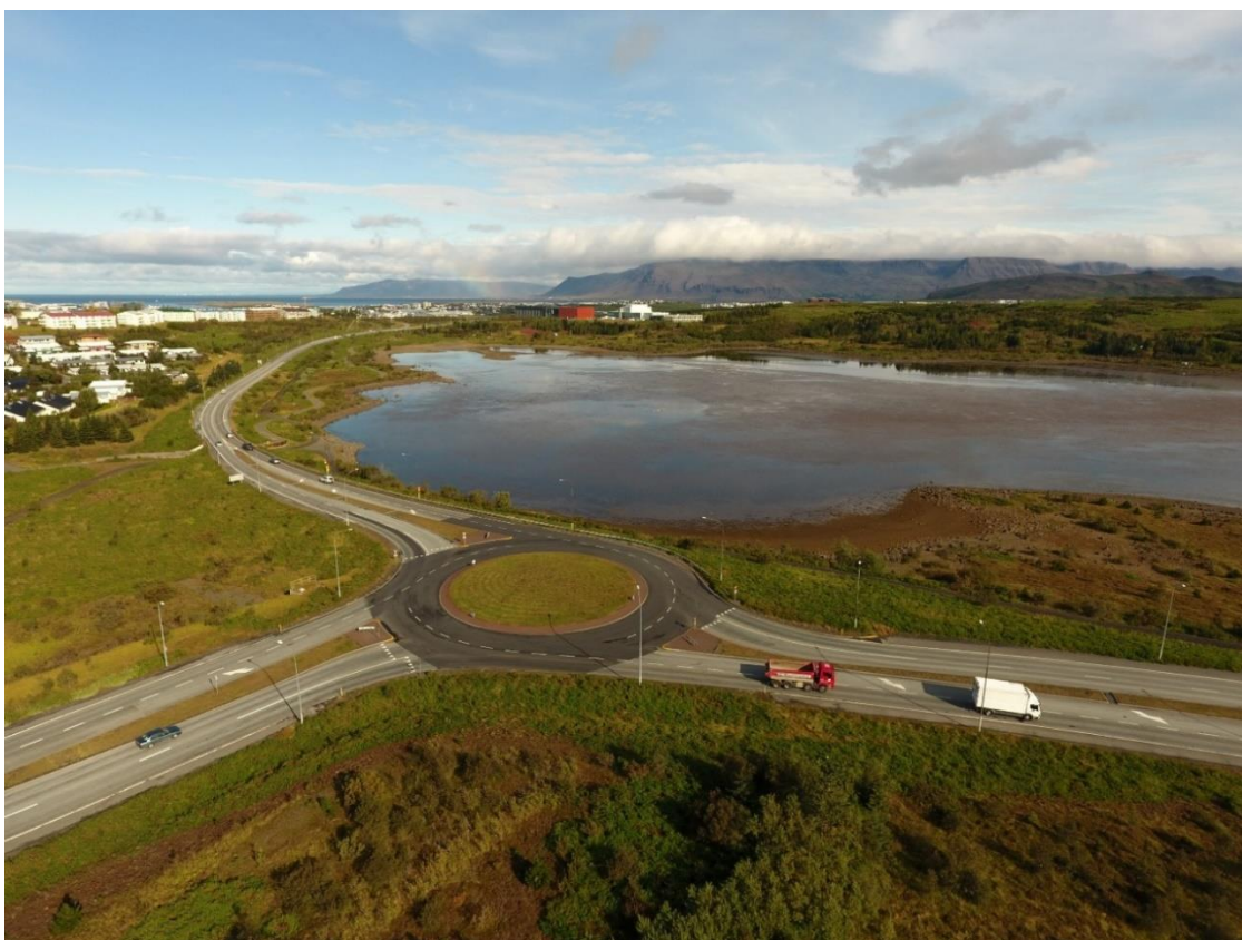
MYND 2.3 Sunnanvert Rauðavatn. Fyllt hefur verið út í vatnið vegna vegar og stíga.
