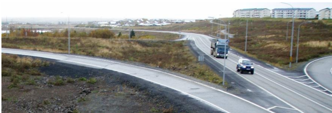
MYND 3.1 Vegamót við Bæjarháls, horft af brú til suðurs. Aðlaga þarf að- og fráreinar.
