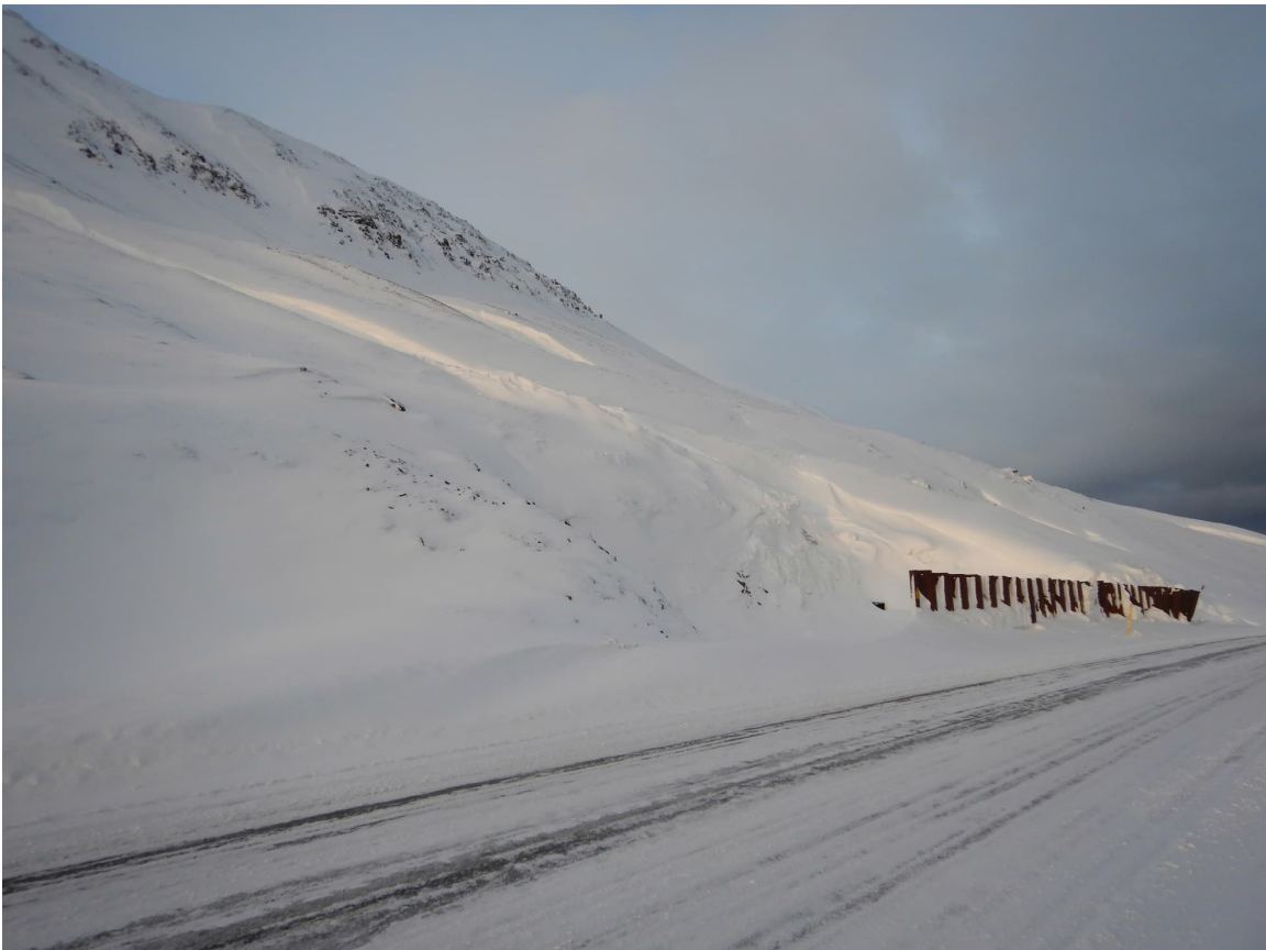
Mynd V14 Snjóflóðaskápur og þil neðan farvegar 36. Sjá má hvernig norðurendi þilsins hefur beyglast eftir flóð.
