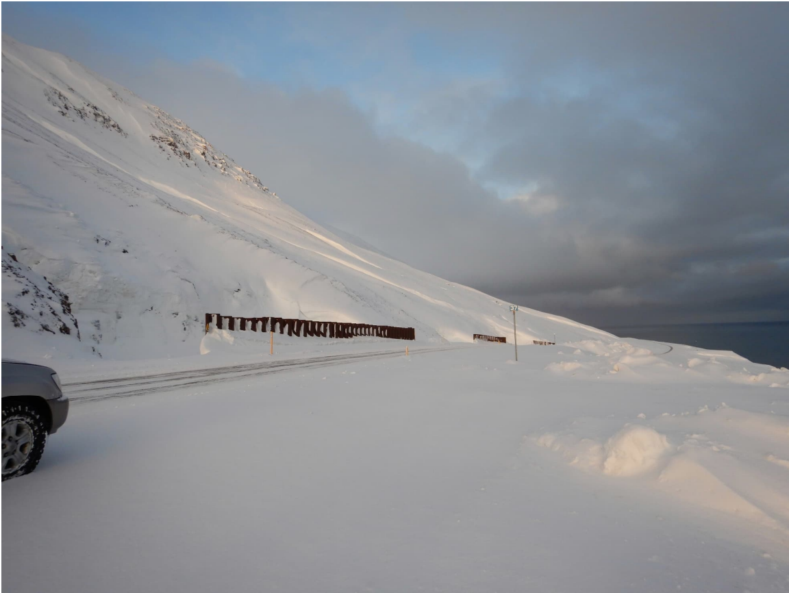
Mynd V15 Snjóflóðaskápar og þil neðan farvega 37 (nær), 36A og 36 (fjær).
