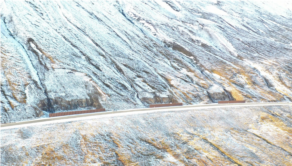
Mynd 4 Snjóflóða skápar neðan farvega 37, 36A og 36.
