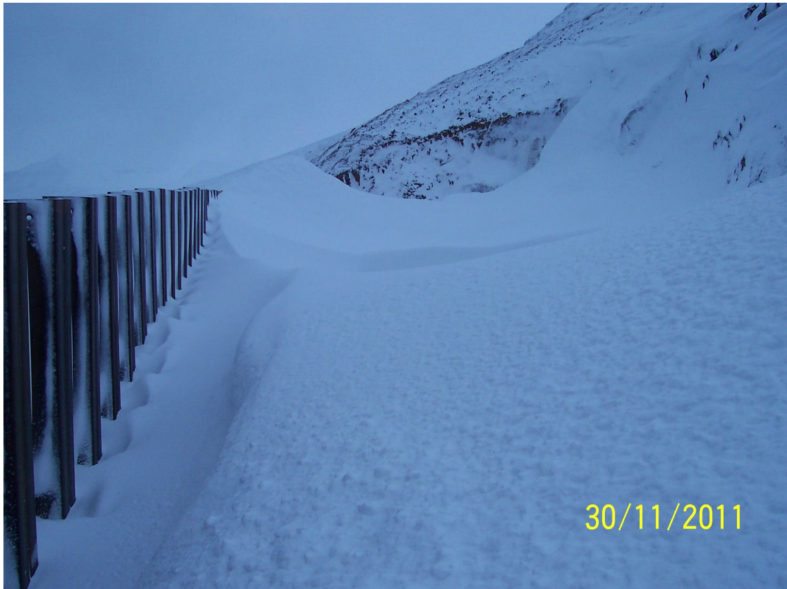
Mynd V4 Flóðsnjór aftan þils í snjóflóðaskápi við Ólafsfjarðarveg. Stálþilið er um 3,5 m hátt. Ljósmyndir frá Gísla Eiríkssyni.
