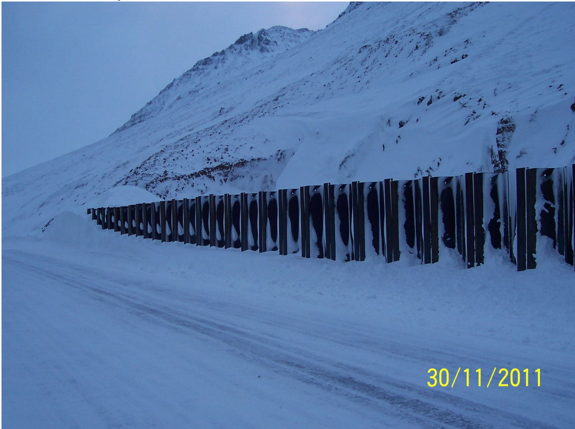
Mynd V5 Flóðsnjór í snjóflóðaskápi við Ólafsfjarðarveg. Stálþilið er um 3,5 m hátt. Ljósmyndir frá Gísla Eiríkssyni.
