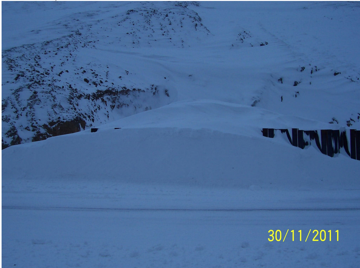
Mynd V3 Flóðsnjór í snjóflóðaskápi við Ólafsfjarðarveg. Stálþilið er um 3,5 m hátt. Ljósmyndir frá Gísla Eiríkssyni.
