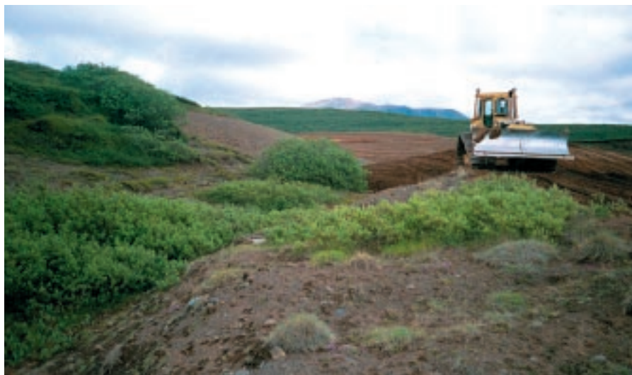
Unnið að frágangi námu við Ferjubakka í Öxarfirði.
