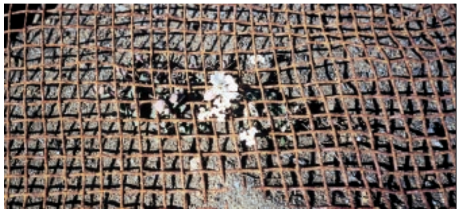
Mynd 4.5: Í námu austan Grindavíkur.
