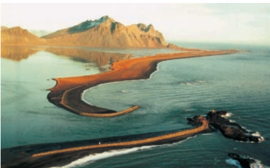
Mynd 6.4: Hér sjást sjóvarnar- og leiðigarðar við Hornafjarðarós. Öldur og straumar móta ströndina að mannvirkjum, sem bafa þann tilgang að frysta ákveðið náttúrulegt jafnvægi. Án þessara mannvirkja myndu náttúrulegar sveiflur loka Ósnum með jöfnu millibili.
