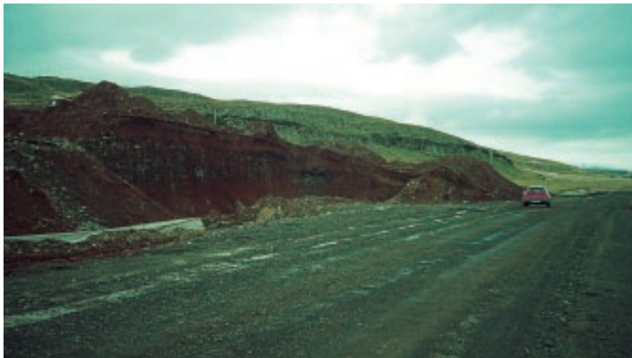
Mynd 7.9: Myndin sýnir óæskilega blöndun jarðvegs og malar.
