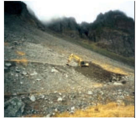
Mynd 9.6: Unnið við frágang Hvalnesnámu. Á myndinni sést námustallur vel.
