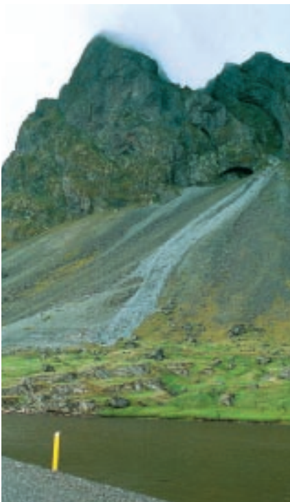
Mynd 9.8: Hvalnesnáma að frágangi loknum. Myndin er tekin ári eftir að frágangi lauk. Skriða befur fallið yfir námusvæði.
