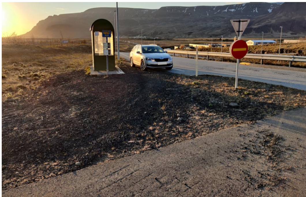
Mynd 3.24 Leirvogstunga í átt að Reykjavík. Engin gangstétt að biðskýli sem er staðsett í miklum halla, bakhlið skýlis snýr að vegi, þ.a. þeir sem sitja á bekk þurfa að snúa sér furðulega til að fylgjast með komandi vögnum. Þörf er á snúningi biðskýlis, sem og tengingu við gönguleiðir.
