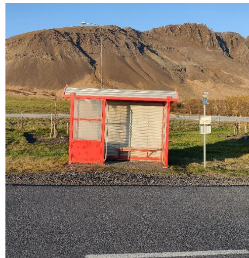
Mynd 3.28 Klébergsskóli í átt að Akureyri. Engar gangstéttir né þveranir eru að stoppi og tímatöflu fyrir leið 57 vantar. Um 2m af mól eru frá biðskýli að malbiki. Æskilegt er að leggja gönguleiðir að biðskýli og steypa umhverfis biðskýlið.
