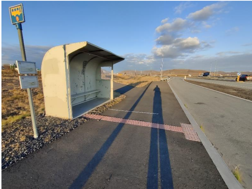
Mynd 3.23 Esjumelar í átt að Akureyri. Leiðarlínur fyrir blinda eru frá biðskýli að innstigi strætó, en ekki að biðskýli annarsstaðar frá. Um 50 cm af mól eru frá malbiki biðstöðvar að strætóskeyli og tímatöflustaur. Æskilegt er að malbika / helluleggja upp að biðskýli.
