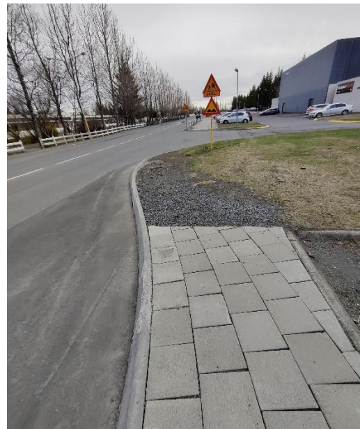
Mynd 3.11 Biðaðstaða við Selfoss – Vallaskóla, þegar ekið er í átt til Hellu. Gangstétt þegar gengið er í átt að skóla endar í möl. Æskilegt er að byggja áfram gangstétt.
