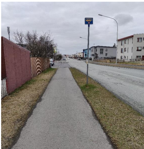
Mynd 3.14 Á biðstöð Hringbrautar / Melateigar á leið til Keflavíkurflugvallar þarf að þvera gras til að komast upp í Strætó. Æskilegt er að leggja hellur / steypa gönguleið í vagn.
