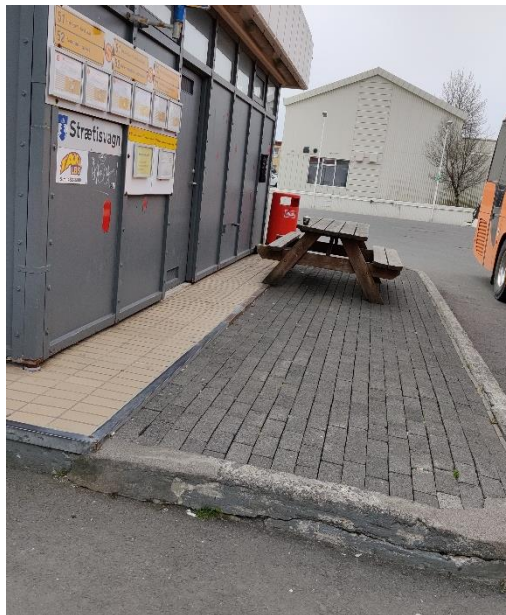
Mynd 3.10 Biðaðstaða við Selfoss – N1. Hér er biðpallur allur upp hækkaður og er hann án niðurtekta. Erfitt getur því reynst fyrir notendur hjólastóla að komast upp á pallinn. Æskilegt er að byggja ramp upp á biðsvæði.
