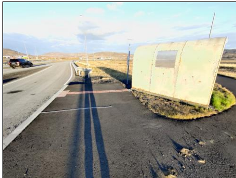
Mynd 3.25 Esjumelarátt átt að Reykjavík. Hér liggja leiðalínur upp að bakhlið biðskýlis. Æskilegt er að endurskoða gerð biðskýlis, til að auðveldara sé að nýta sér kosti þess.
