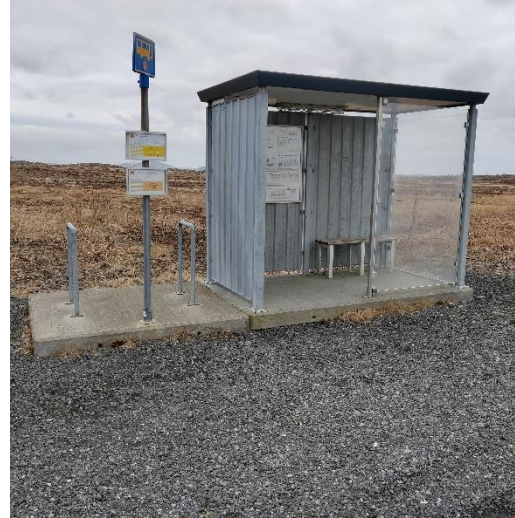
Mynd 3.17 Biðskýli við Grindarvíkurafleggjara, á leið til Reykjavíkur. Hér er hátt þrep (18cm) upp í biðskýlið sem stendur á þéttri mól. Hér er að finna hjólastanda. Æskilegt væri að steypa biðsvæði, þ.a. hvorki sé hæðarmunur við gönguleiðir né biðskýli.
