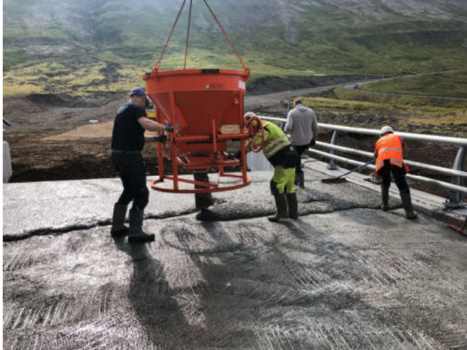
Mynd 18. Slitlagssteypa lögð á brú yfir Botnsá.
