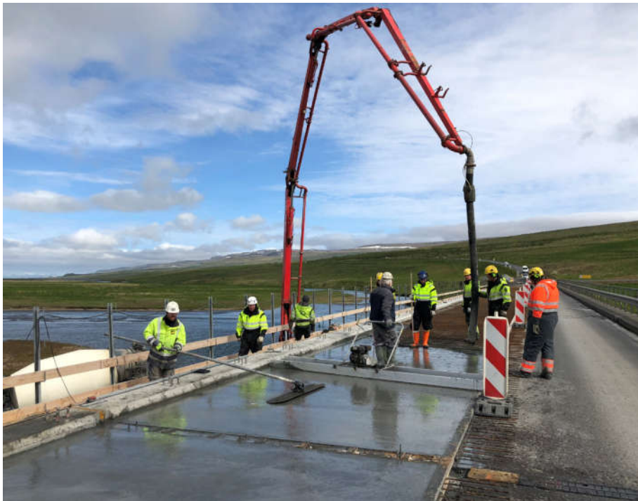
Mynd 33: Steypt slitlag lagt út á brú yfir Miðfjarðará.
