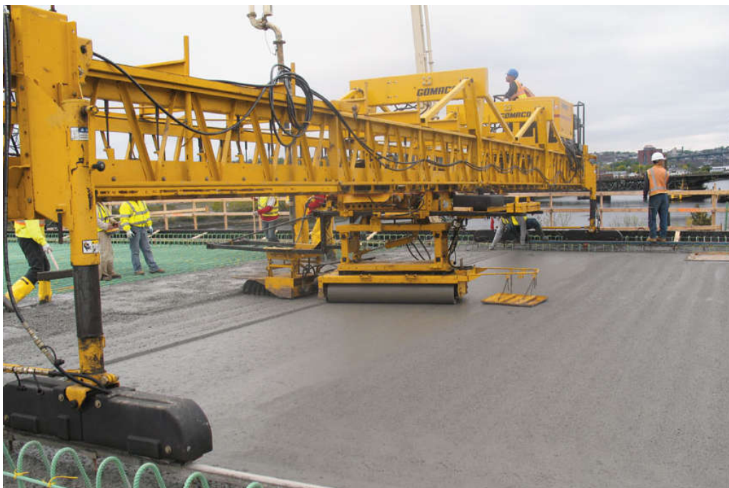
Mynd 35: Dæmi um hentuga útlagningarvél fyrir steyppt slitlag, sem notuð er víða erlendis. Steypunni er dælt þannig að aðflutningur á steypu helst stöðugur.
