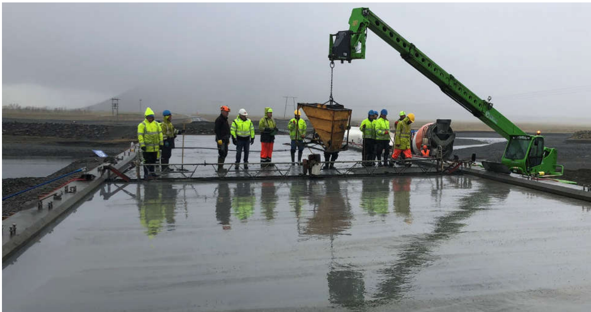
Mynd 30: Steypt slitlag á nýrri brú yfir Steinavötn í Suðursveit.
