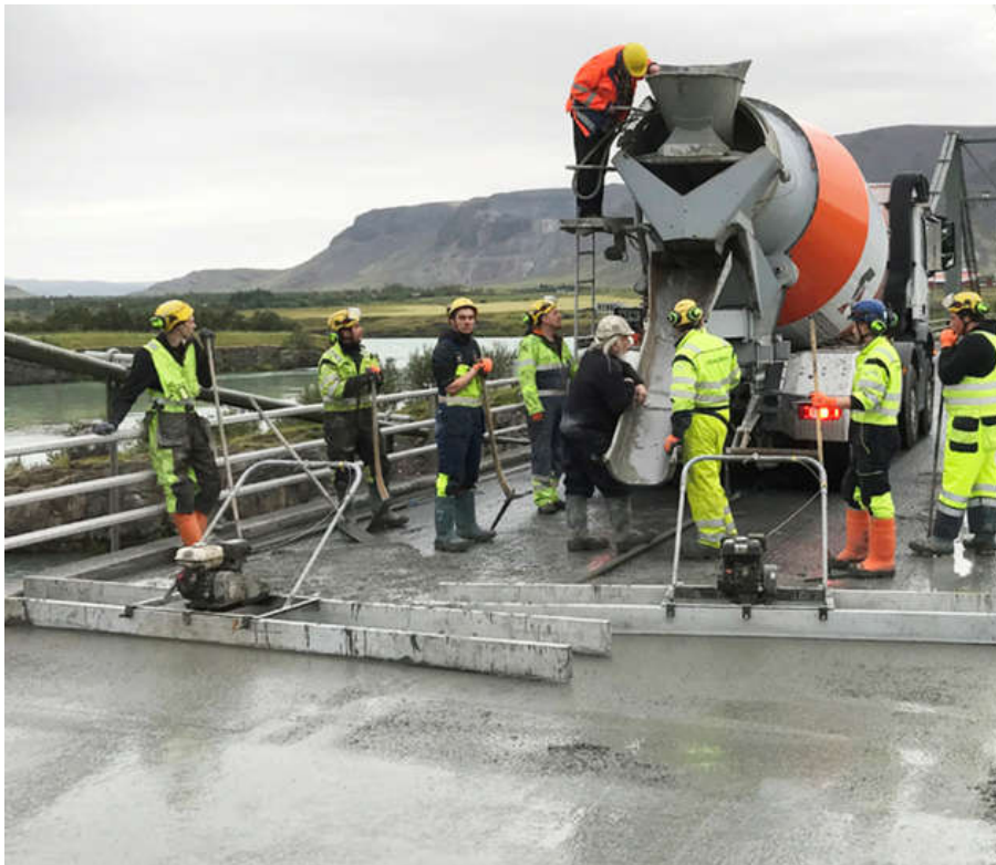
Mynd 34: Steypt slitlag lagt út á brú yfir Ölfusá.
