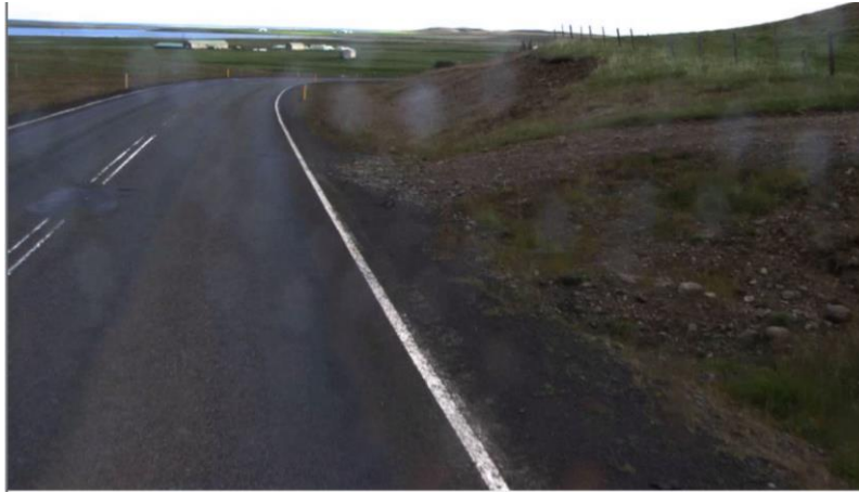
Mynd 46 – Hringvegur (1-k8), tenging vinstra megin í stöð 10130 sumið 2018.
