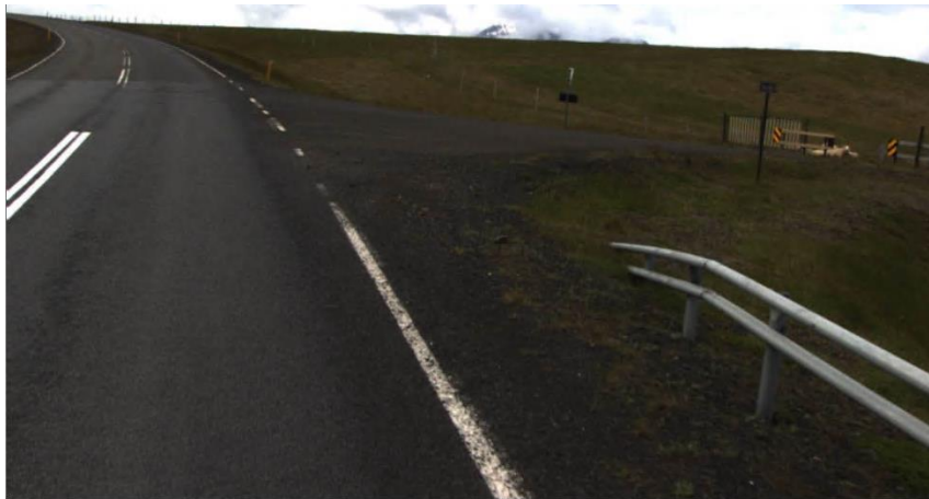
Mynd 47 – Hringvegur (1-k8), tenging vinstra megin við Litlu-Giljá í stöð 10380 sumarið 2018.
