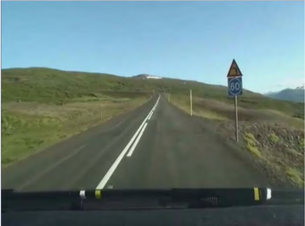
Mynd 6. Horft fram veg 93-02. Hvítu línurnar á rúðupurkunnni marka u.þ.b. 3,25 m vegbreidd en gulu línurnar marka u.þ.b. 2,75 m vegbreidd.
