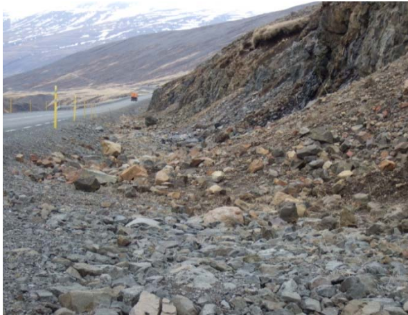
Mynd 15 og 16 Fyrir og eftir að grjót sem hefur hrunið í skeringu hefur verið fjarlæggt
