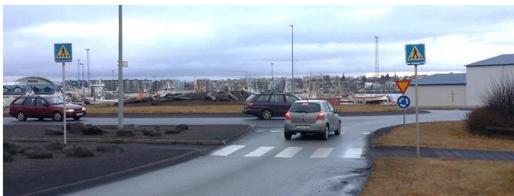
Mynd 20 Gangbraut við hringtorg merkt með umferðarmerkjum og yfirborðsmerkingu. Æskilegt er að a.m.k. 5 m séu frá gangbraut að biðskyldu. Eins og sjá má er rými fyrir ökutæki milli gangbrautar og hringtorgs.
