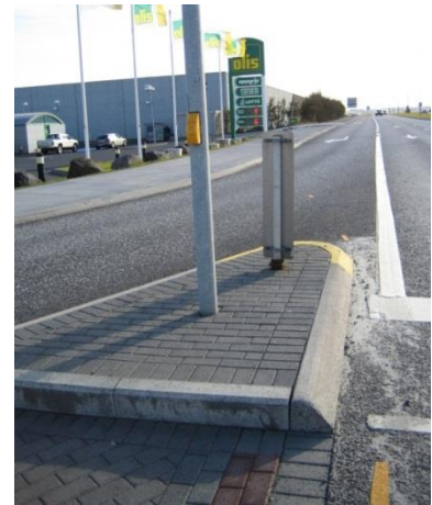
Mynd 4 Hnappur við umferðarljós staðsettur þannig að hann er ekki aðgengilegur öllum.
