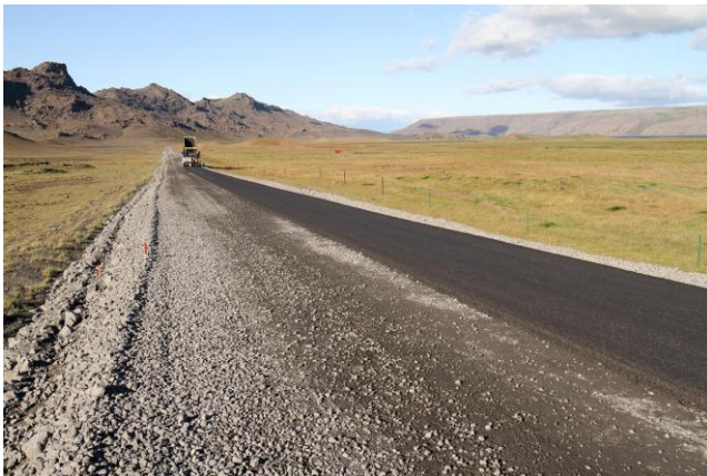
Mynd 6. Yfirborð á seinni akrein varð nokkuð gróft vegna umferðar
