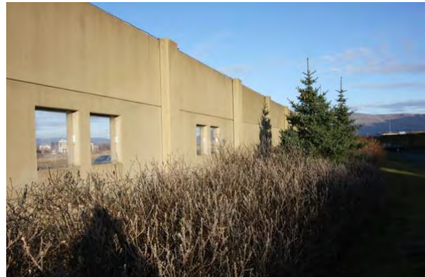
Mynd 3-12: Steypur veggur við Sæbraut, séð frá íbúðum
