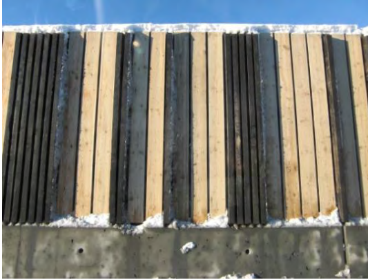
Mynd 3-16: Timburveggur í Garðbæ, með steypum undirstöðum.
