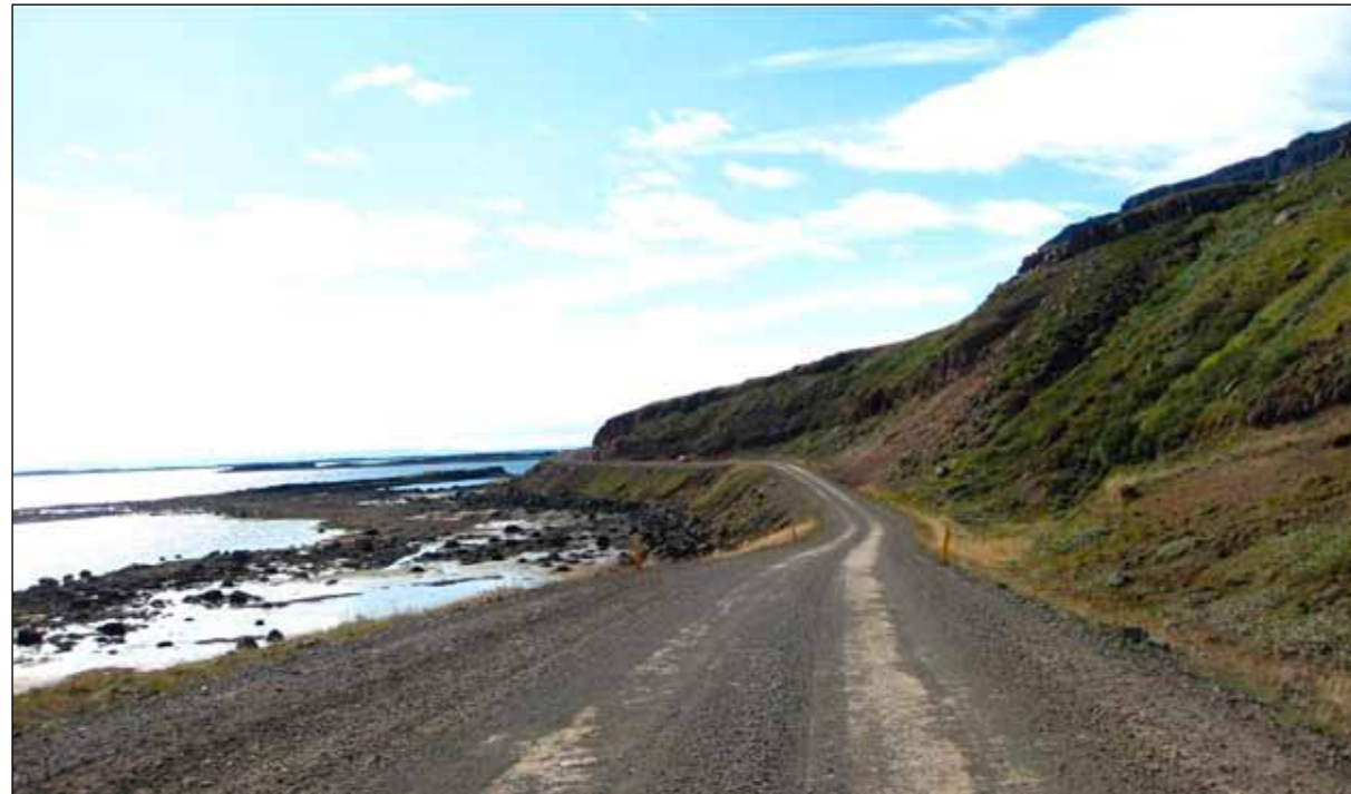
Matsskýrslunni fylgja 13 viðaukar. Einn þeirra er mat á áhrifum veg framkvæmda á landslag. Þar er fjöldi mynda sem sýna breytingar á landslagi með tölvugerðum þrívíddarmyndum. Hér er dæmi sem sýnir hamar í Kirkjubólslífi, á milli stöðva 5500-5600. Skorðið verður af hamrinum auk þess sem fyllingar verða settar niður í fjöruna á um 90 m kafla þar sem hún kemur mest inn.
