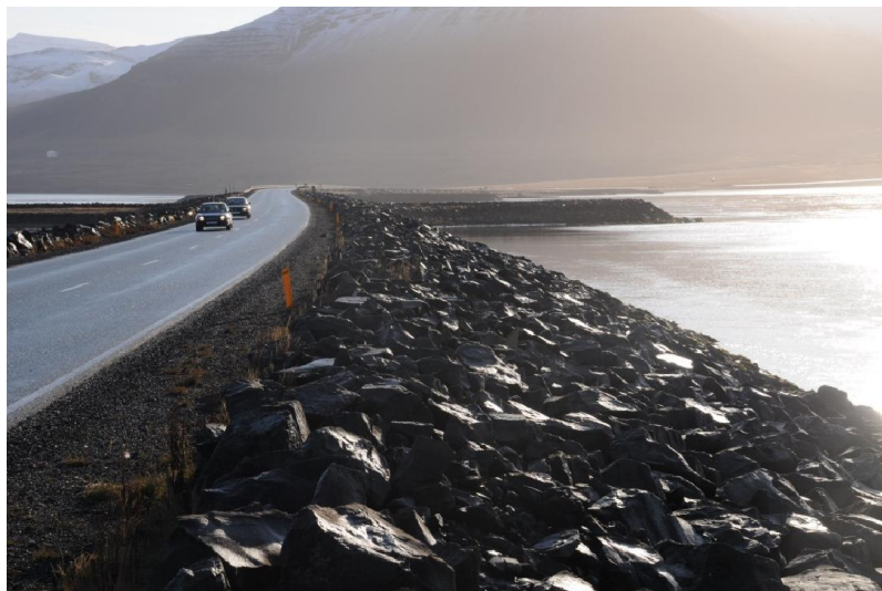
Hringvegur 1 Borgarfjarðarbrú og grjótvörn
