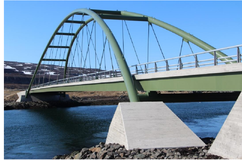
Brú yfir Mjóafjörð í Djúpi
