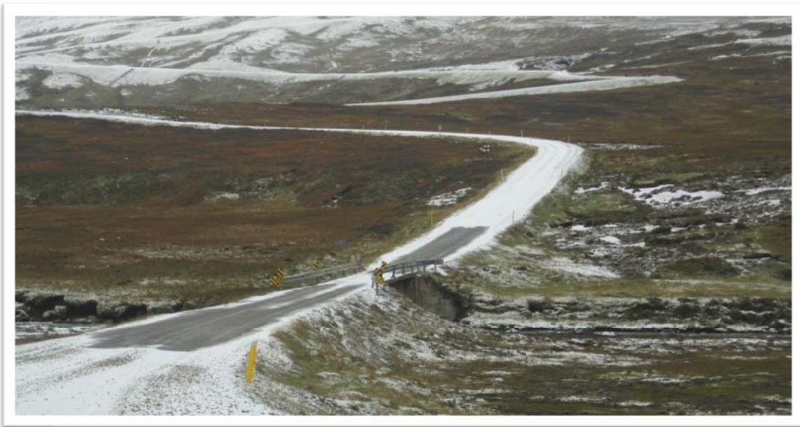
Mynd 2: Einbreið brú við brekkurætur yfir Njarðvíkurá.
