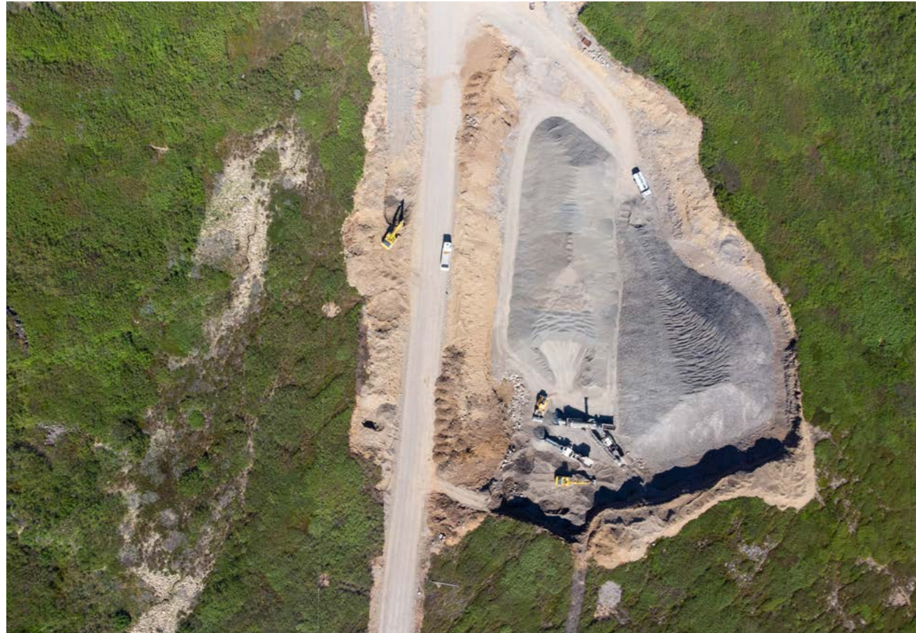
↑ Námuvinnsla í tengslum við framkvæmdir við Vesturlandsveg (60) um Gufudalssveit. Mynd: Haukur Sigurðsson
