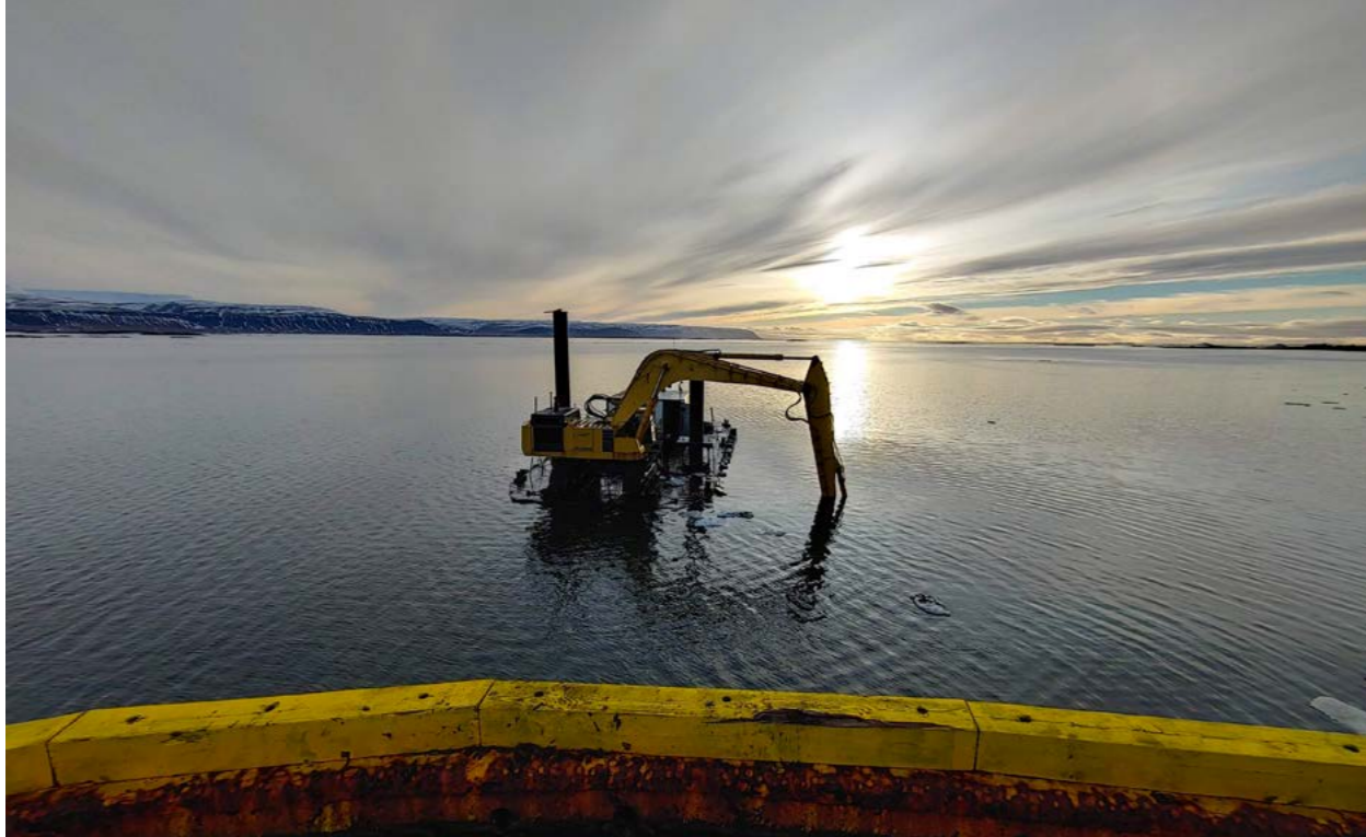
↑ Undirbúningur í Reykhólahöfn vegna fyrirhugaðra framkvæmda við stálþilsrekstur.
