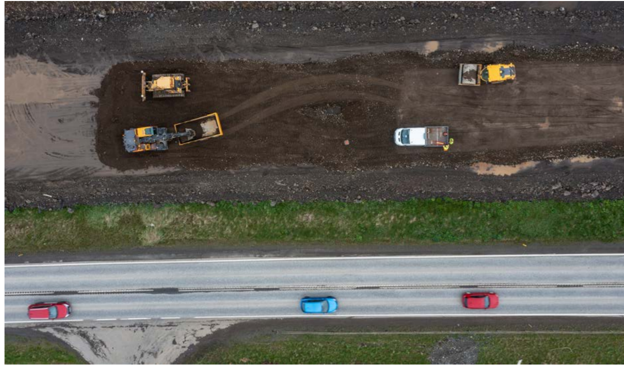
↑ Framkvæmdir við breikkun Vesturlandsvegur (1) á Kjalarnesi. Mynd: Vilhelm Gunnarsson.
