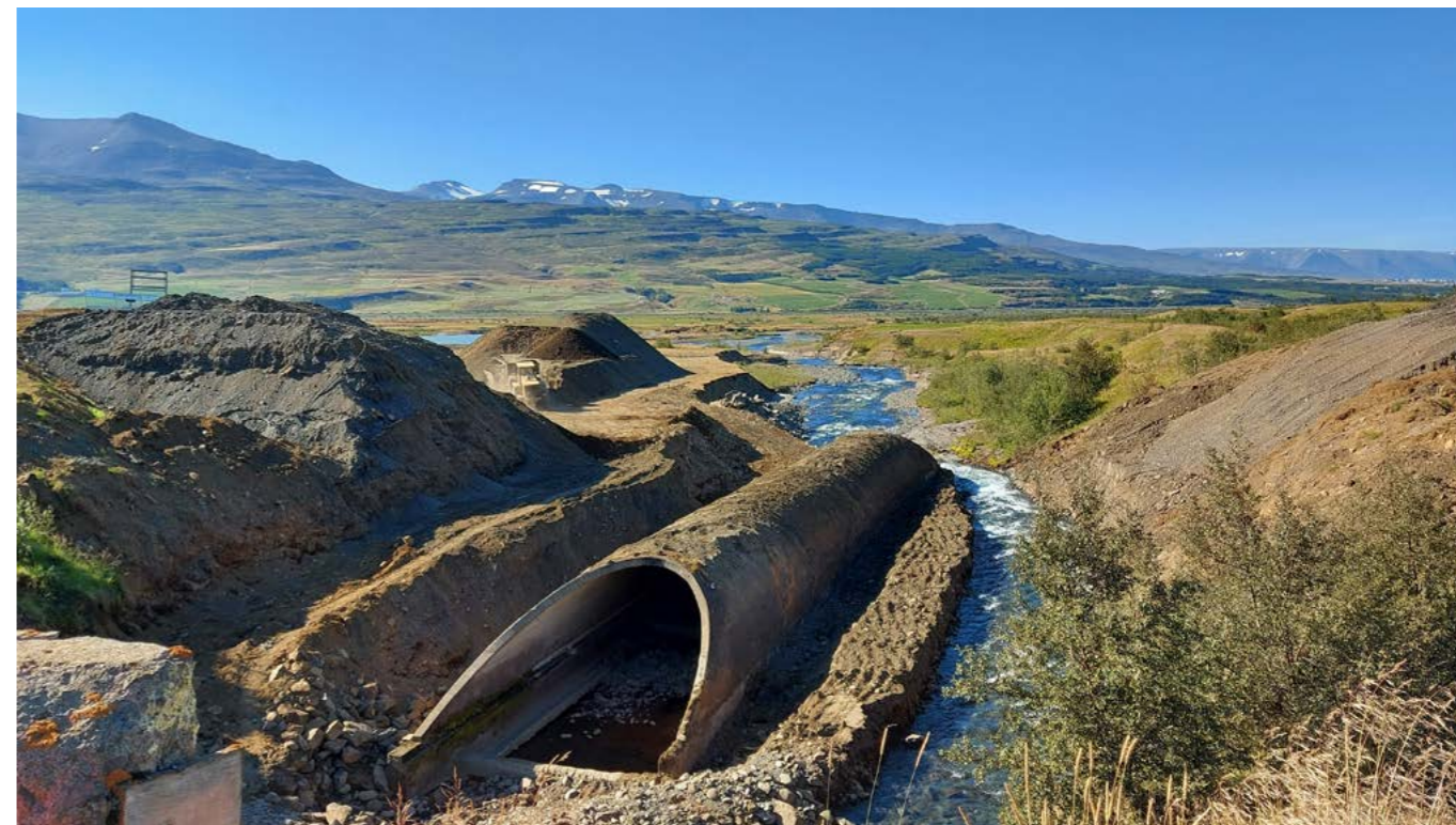
Framkvæmdir við ræsi yfir Þverá í Kaupangssveit í ágúst 2021. Ræsið skemmdist í kjölfar mikilla flóða og neðri hluti ræsisins var endurbýggður.
