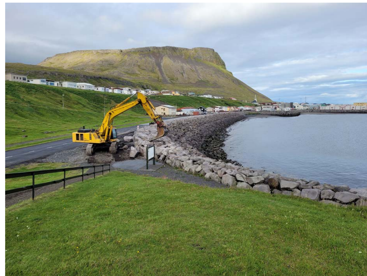
Unnið að endurbyggingu og styrkingu sjóvarnar við Ólafsbraut í Ólafsvík.
