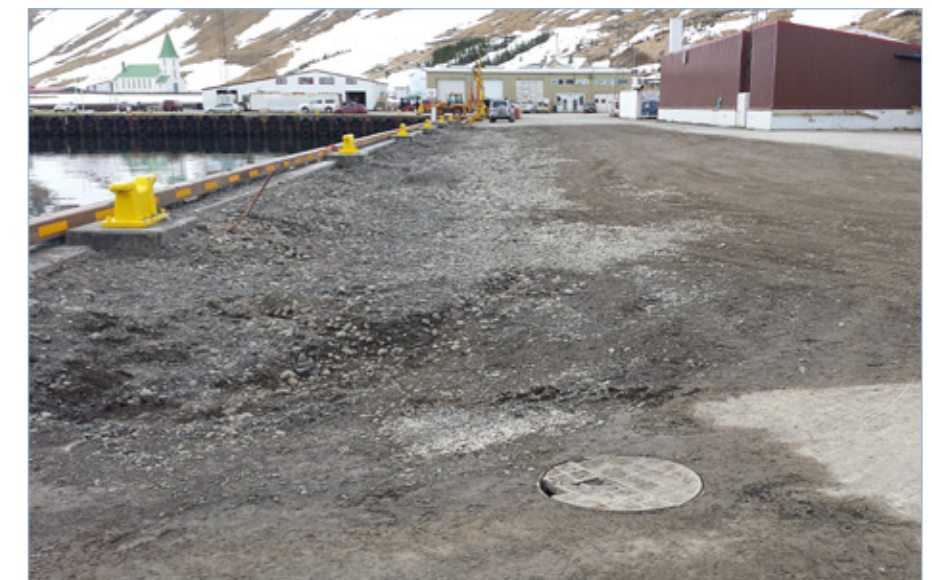
Suðureyri fyrir framkvæmdir, 9. apríl 2014.
