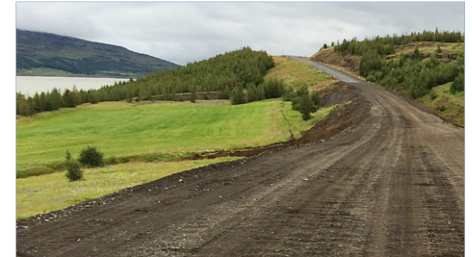
Upphéraðsvegur (931) vegagerð, 29. júlí 2014.
