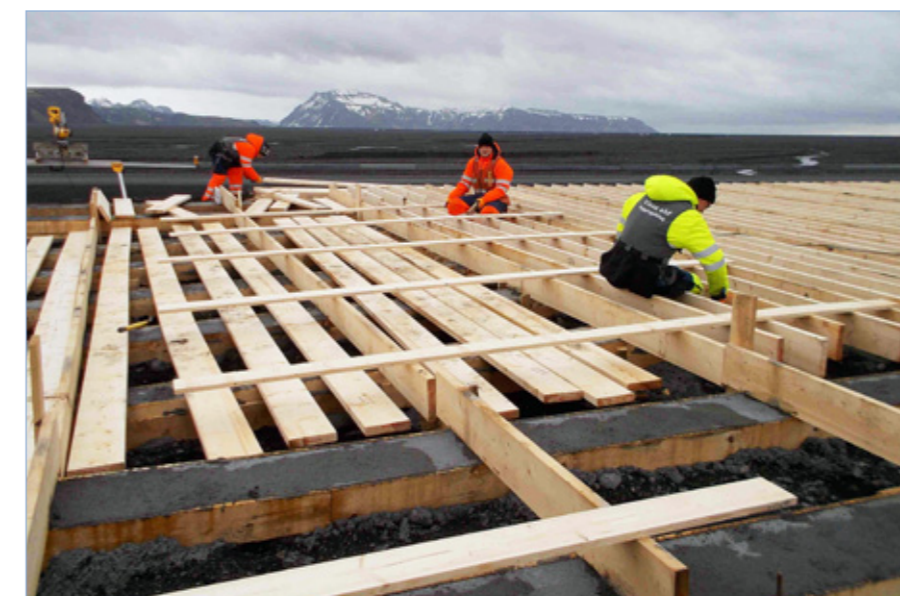
Hringvegur (1), brúargerð á Múlakvísl, 3. apríl 2014.
