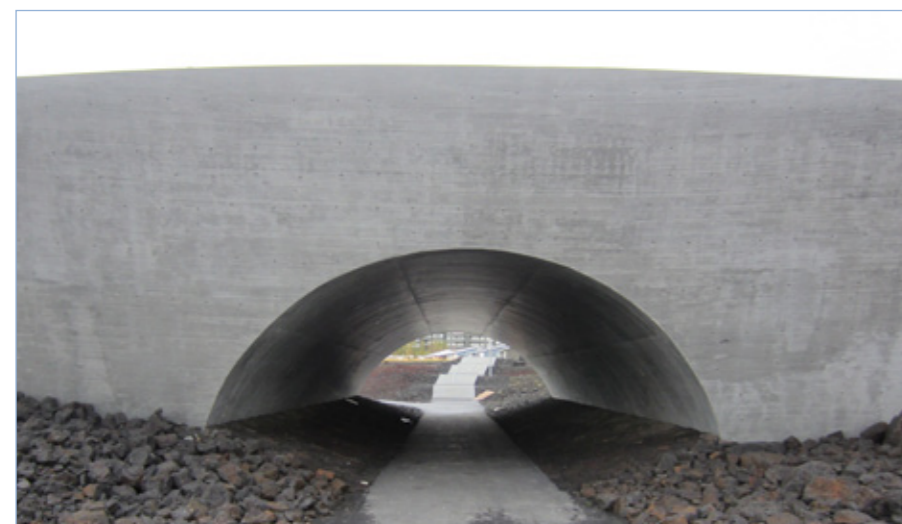
Reykjanesbraut (41), undirgöng við Hvaleyrarholt, 2. október 2014.
