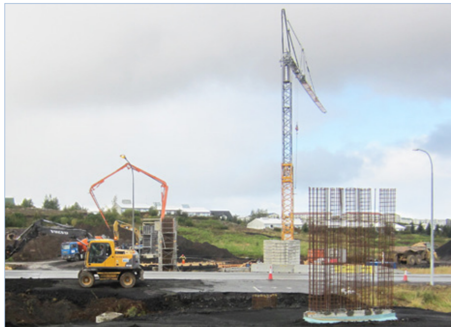
Breiðholtsbraut (413), bygging göngubrúar við Norðlingaholt, 9. september 2014.
