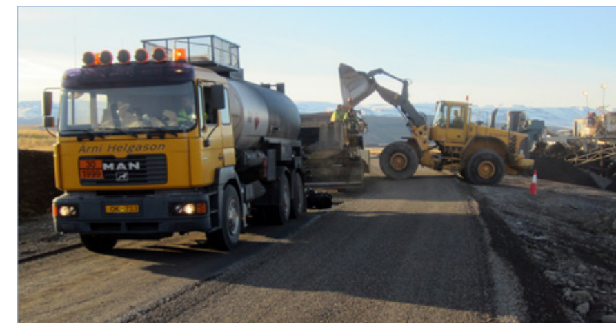
Staðarbraut (854), 24. september 2013. Klæðingarefninu mokað beint úr námu í malardreifara.
