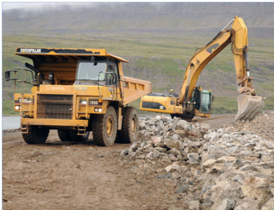
Vestfjarðavegur (60), Eiði - Þverá. Fylling yfir Kjálkafjörð, 25. ágúst 2014.
