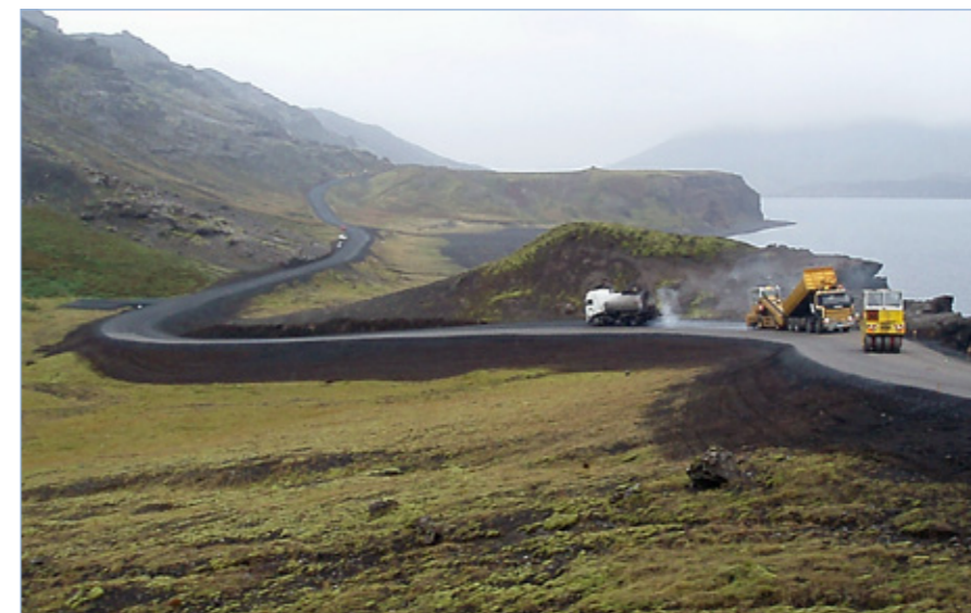
Krýsuvíkurvegur (42), klæðing 17. september 2014.
