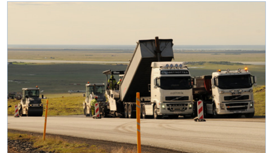
Hringvegur (1), malbikun í Kambabrekku, 29. júlí 2014.
