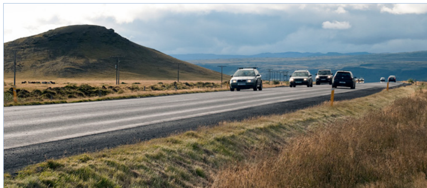
Hringvegur (1), Selfoss – Hveragerði. Unnið er að undirbúningi og hönnun endurbóta á þessum vegarkafli.
