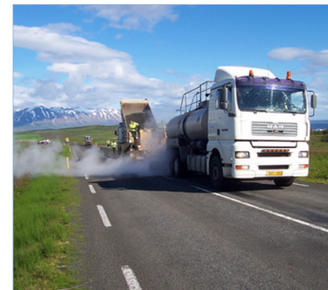
Ólafsfjarðarvegur (82) við Hauganes, yfirlögn með bikþeytu, 17. júlí 2014.
