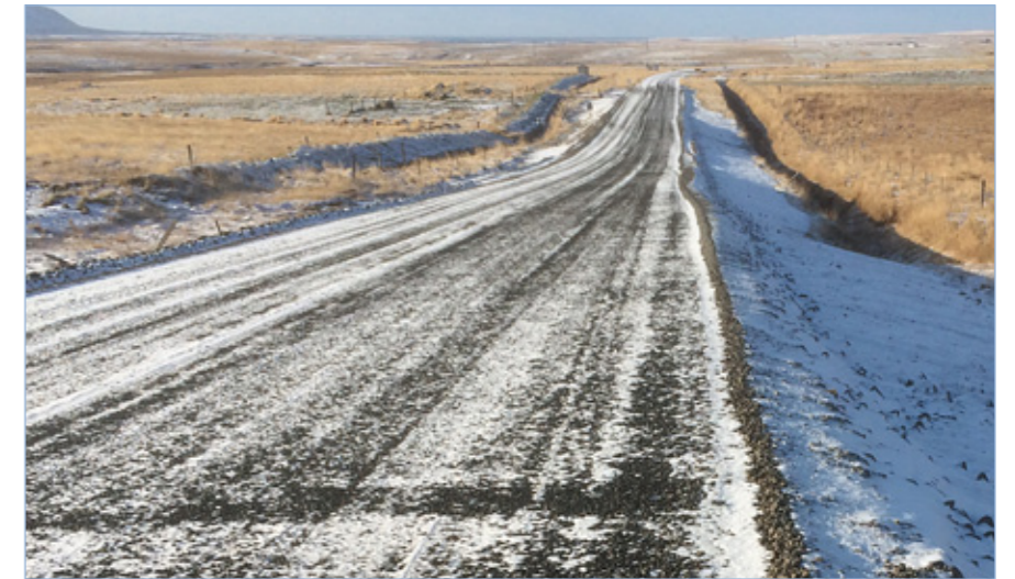
Svínadalsvegur (502) nýtt bundið slitlag, ófrágengin vegöxl, 21. október 2014.
