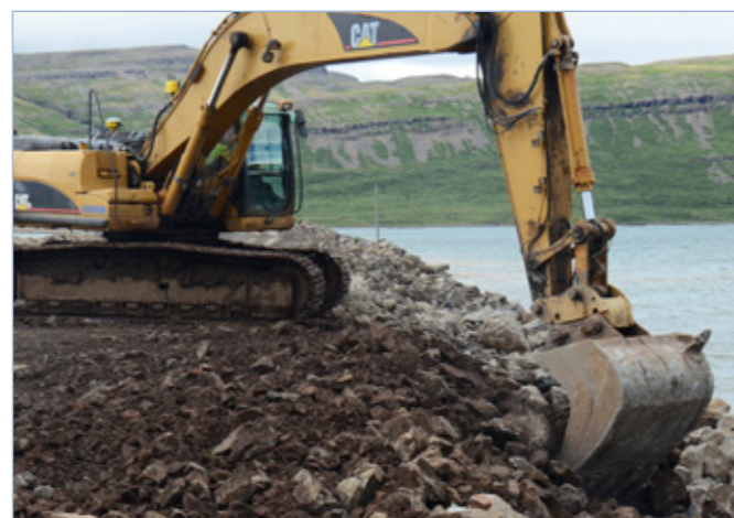
Vestfjarðavegur (60), Eiði - Þverá. Grjótvörn raðað í Kjálkafirði, 2. júlí 2014.
