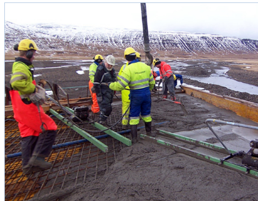
Vestfjarðavegur (60) um Reykjadalásá. Steypuvinna í brúargerð 2014.
