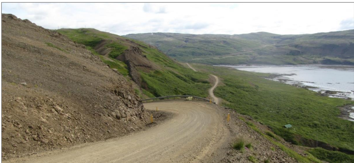
Mynd 24. Kröpp beygja á núverandi vegi á Ódrjúgshálsi Djúpafjarðarmegin (ljósmynd: Vegagerðin, 2012).
