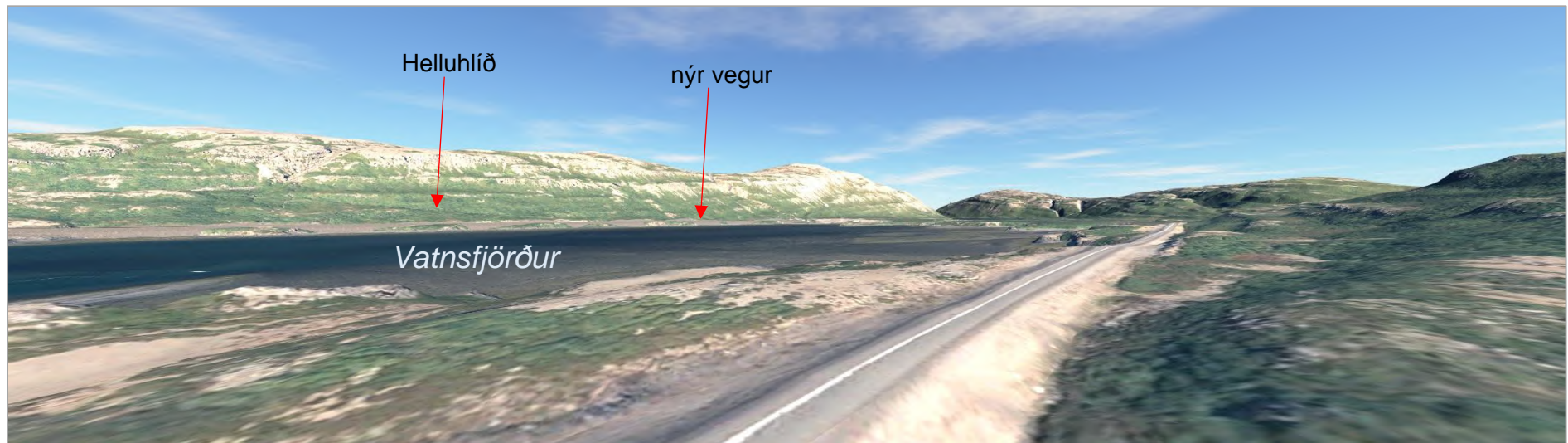
Mynd 1b.2. Horft inn Vatnsfjörð að austanverðu og að Helluhlíð. Veglína A1, A2 og A3 að loknum framkvæmdum.
