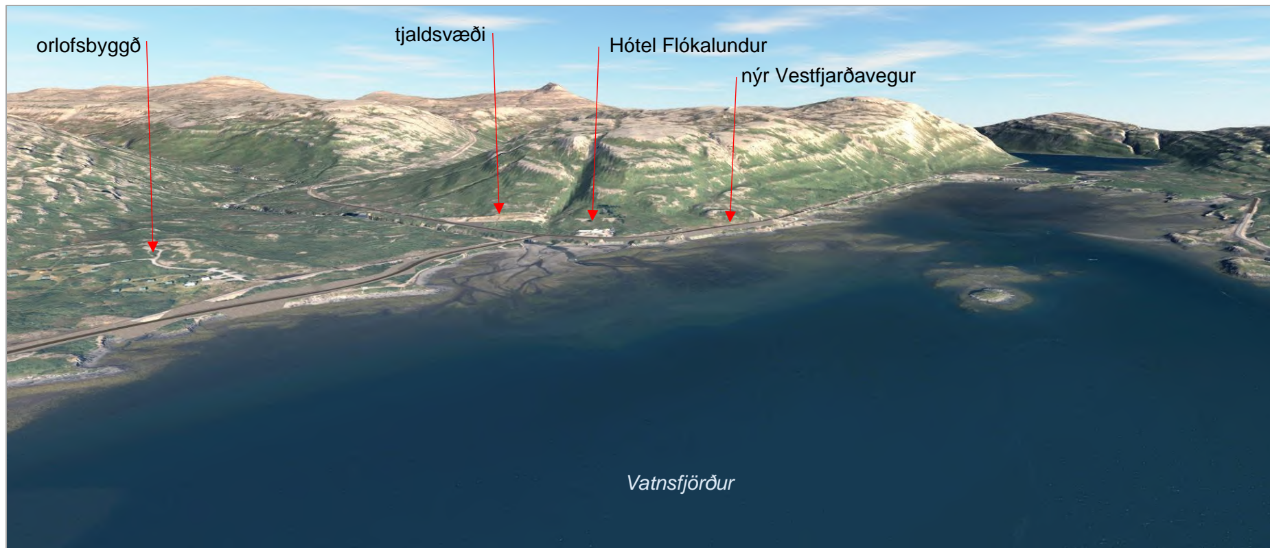
Mynd 14.1b. Veglína A1 að loknum framkvæmdum í Vatnsfirði.
