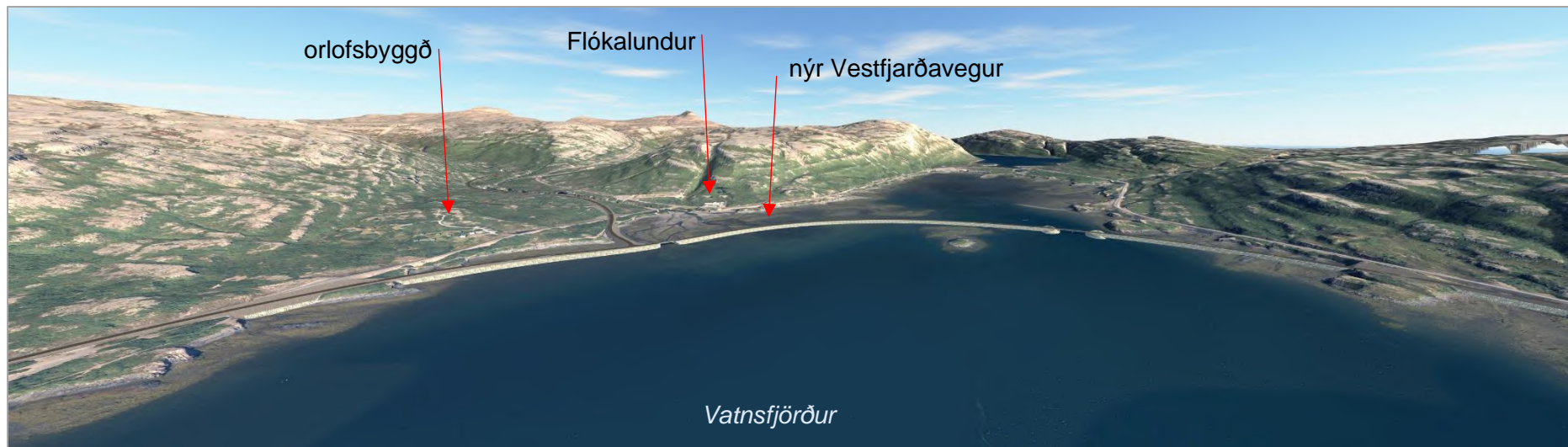
Mynd 14.4a. Veglína F3 að loknum framkvæmdum í Vatnsfirði.
