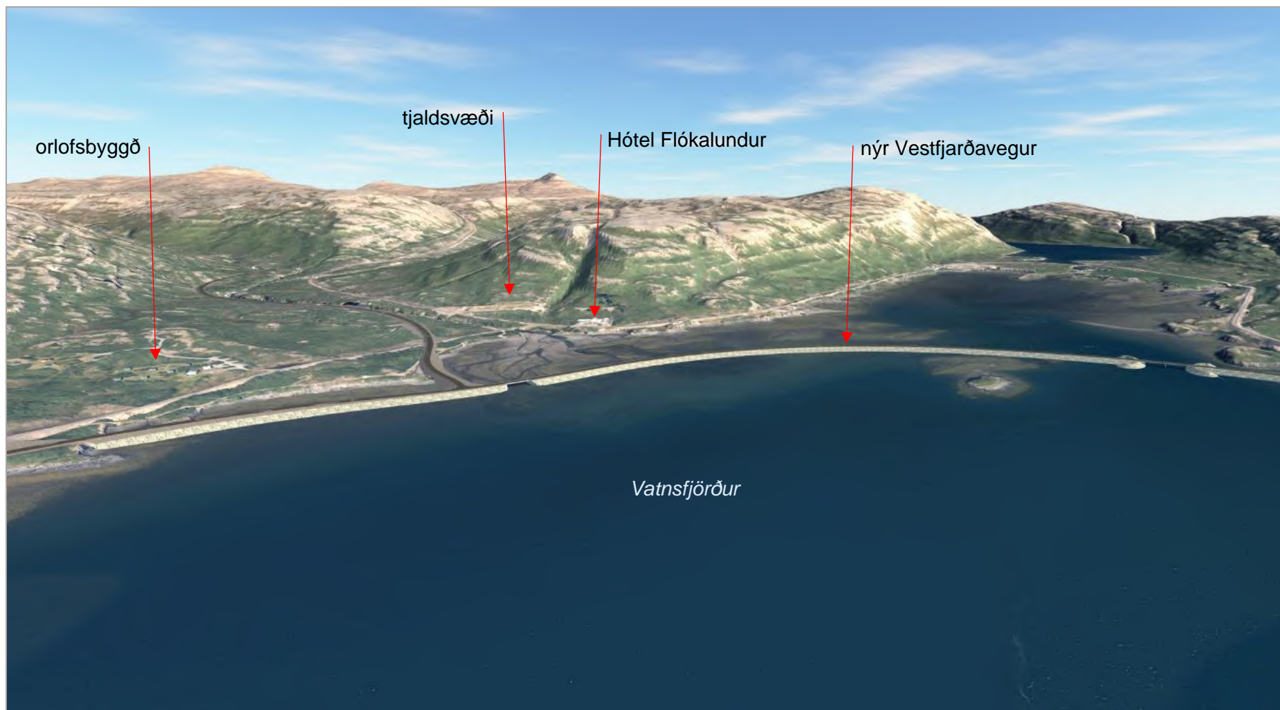
Mynd 14.4b. Veglína F3 að loknum framkvæmdum í Vatnsfirði.
