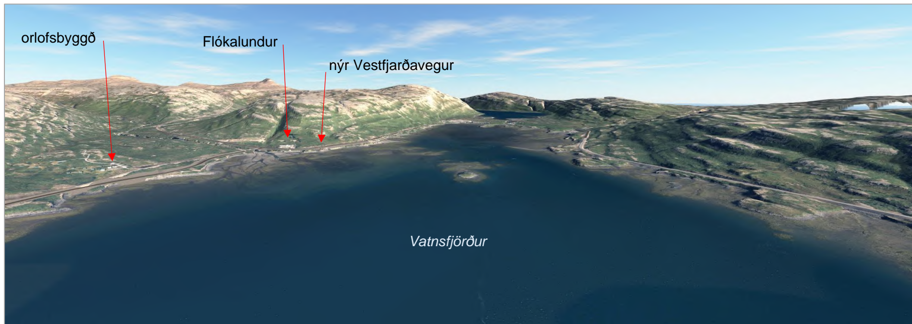
Mynd 14.1a. Veglína A1 að loknum framkvæmdum í Vatnsfirði.
