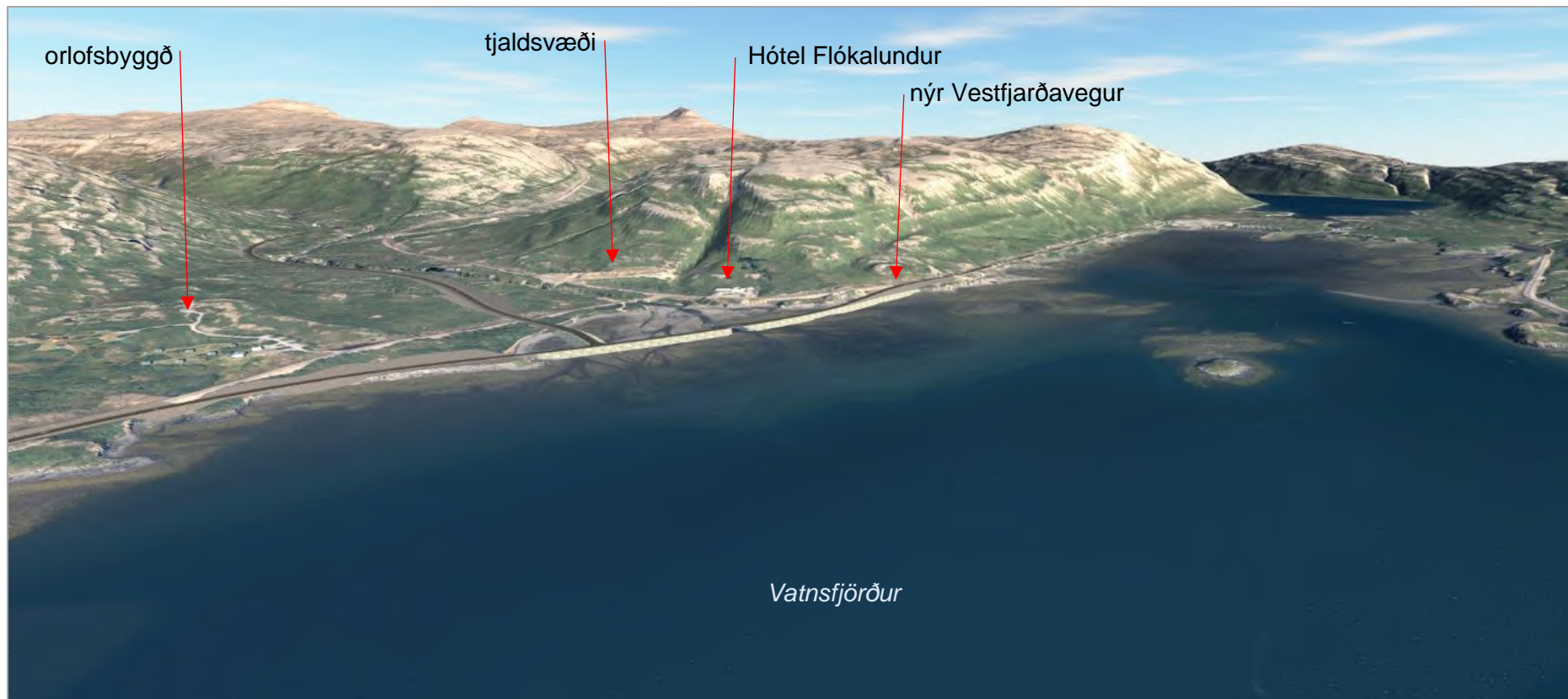
Mynd 14.2b. Veglína A2 að loknum framkvæmdum í Vatnsfirði.
