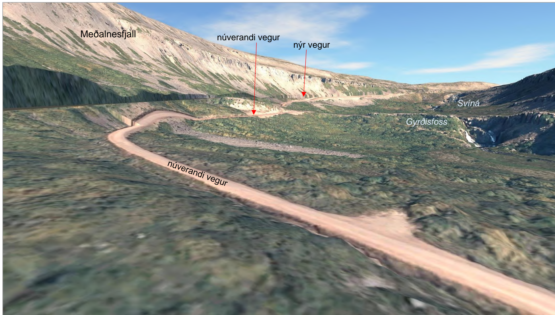
Mynd 20.6. Horft upp Dynjandisdal frá útskoti við Gyrðisfoss í Svíná. Veglína D þegar gróður hefur náð sér á strik. Líklega verður núverandi vegur græddur upp.
