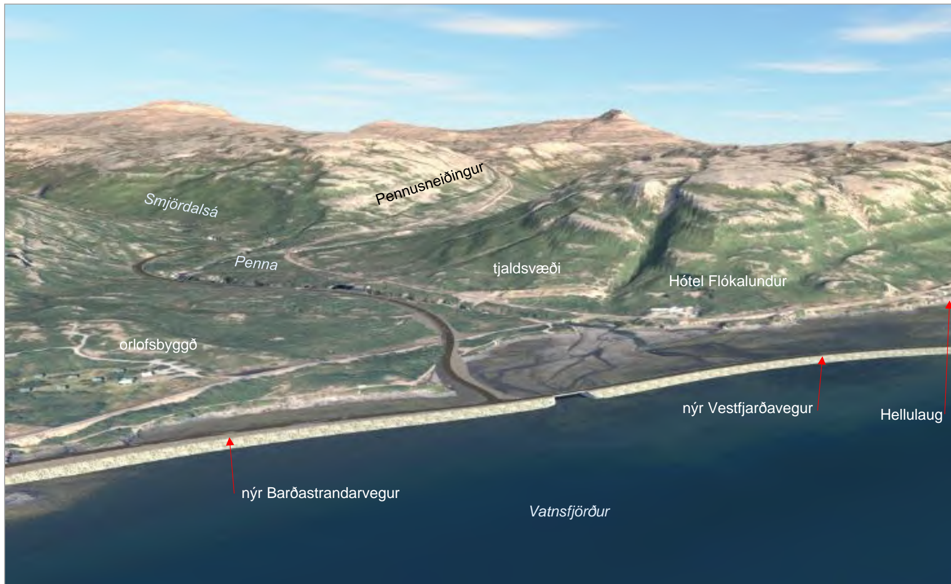
Mynd 14.4c. Veglína F3 að loknum framkvæmdum í Vatnsfirði.
