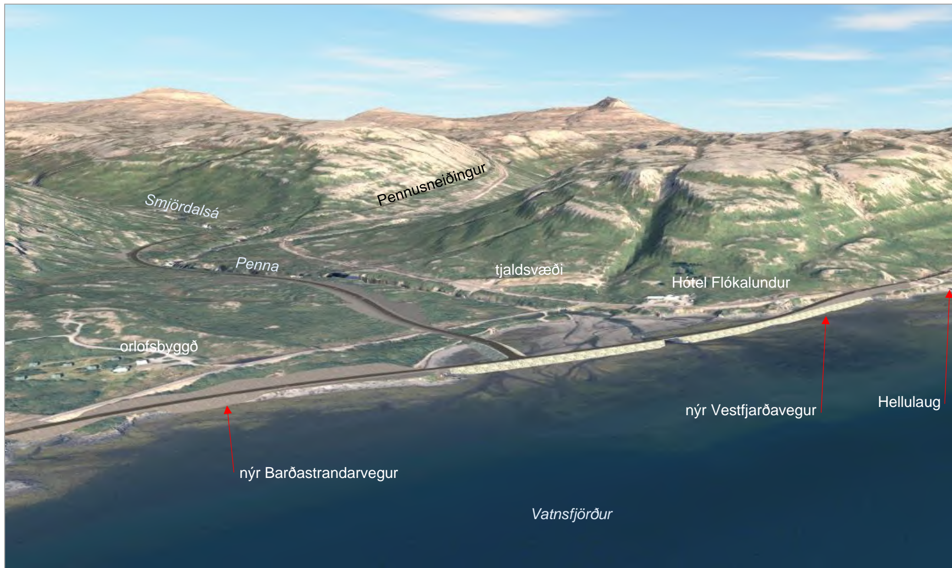
Mynd 14.2c. Veglína A2 að loknum framkvæmdum í Vatnsfirði.
