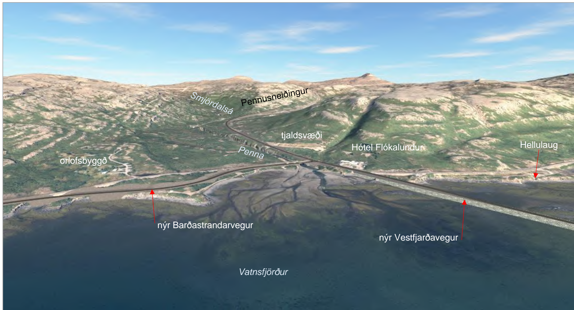
Mynd 15.4b. Veglína F2 að loknum framkvæmdum við Flókalund í Vatnsfirði.
