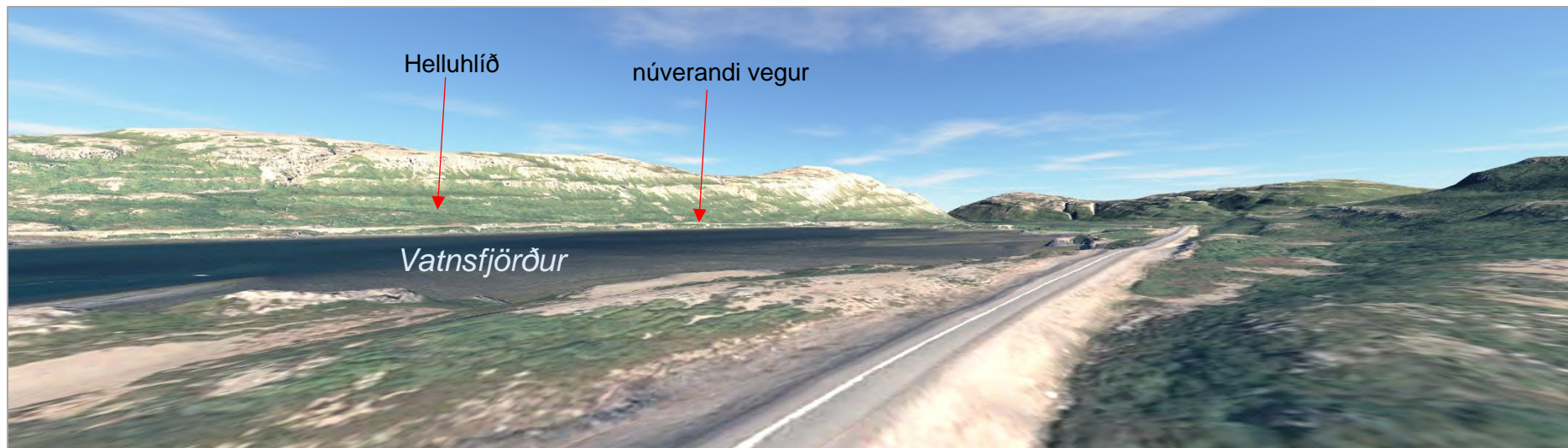
Mynd 1b.3. Horft inn Vatnsfjörð að austanverðu og að Helluhlíð. Veglína F, F2 og F3 að loknum framkvæmdum.
