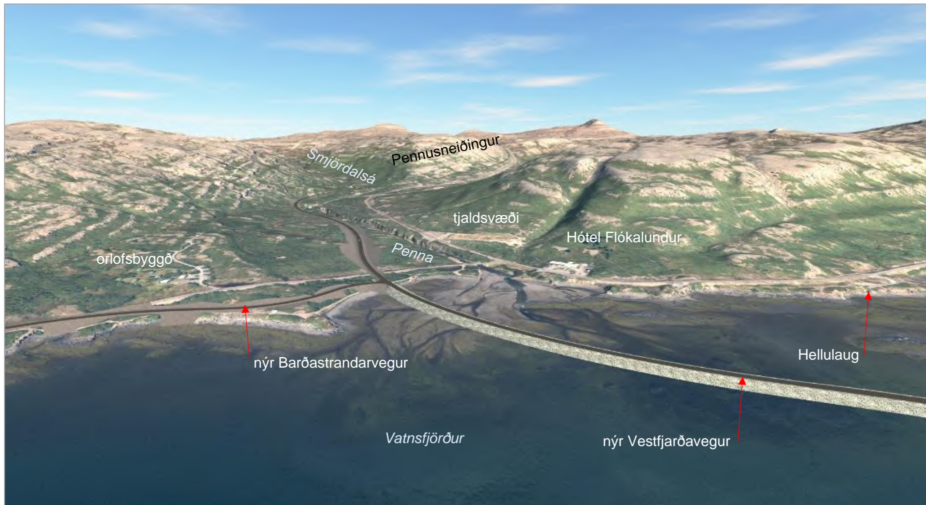
Mynd 15.3b. Veglína F að loknum framkvæmdum við Flókalund í Vatnsfirði.
