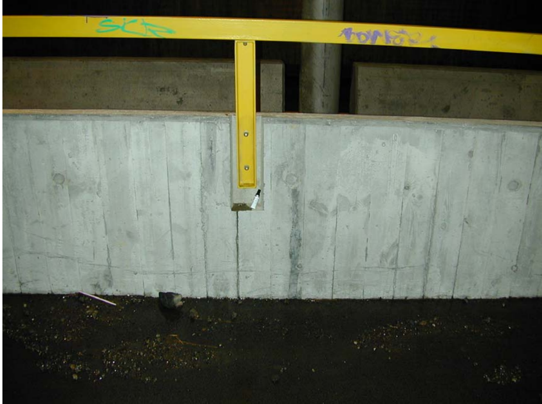
Mynd 19. Staðsetning á rauf í steypu. Raufin er um 10 cm víð, um 5 cm djúp og tæplega 40 cm löng.
