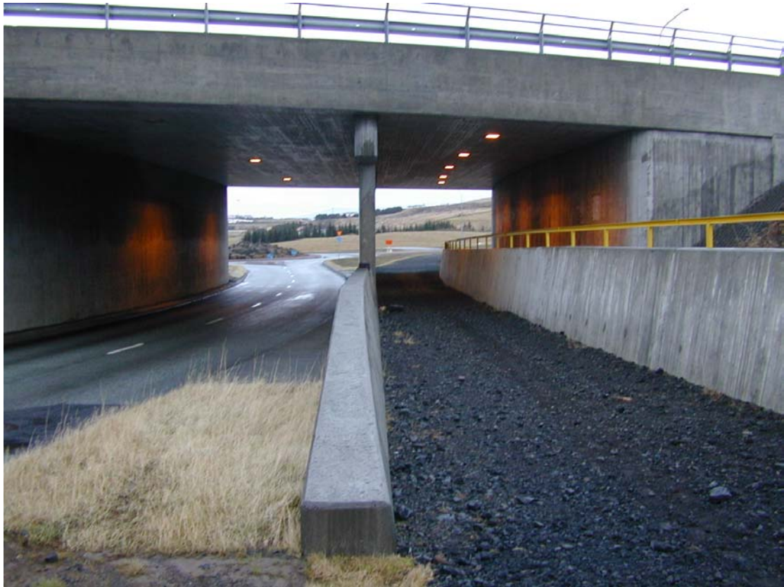
Mynd 15. Umferðabrá á Vesturlandsvegi. Veggirnir sitt hvoru megin við reiðgötuna voru kannaðir með NDT-tækinu. Staðsetning mælipunkta á veggnum vinstra megin eru sýndir á mynd 17 og staðsetning mælipunkta á veggnum hægra megin eru sýndir á mynd 19.
