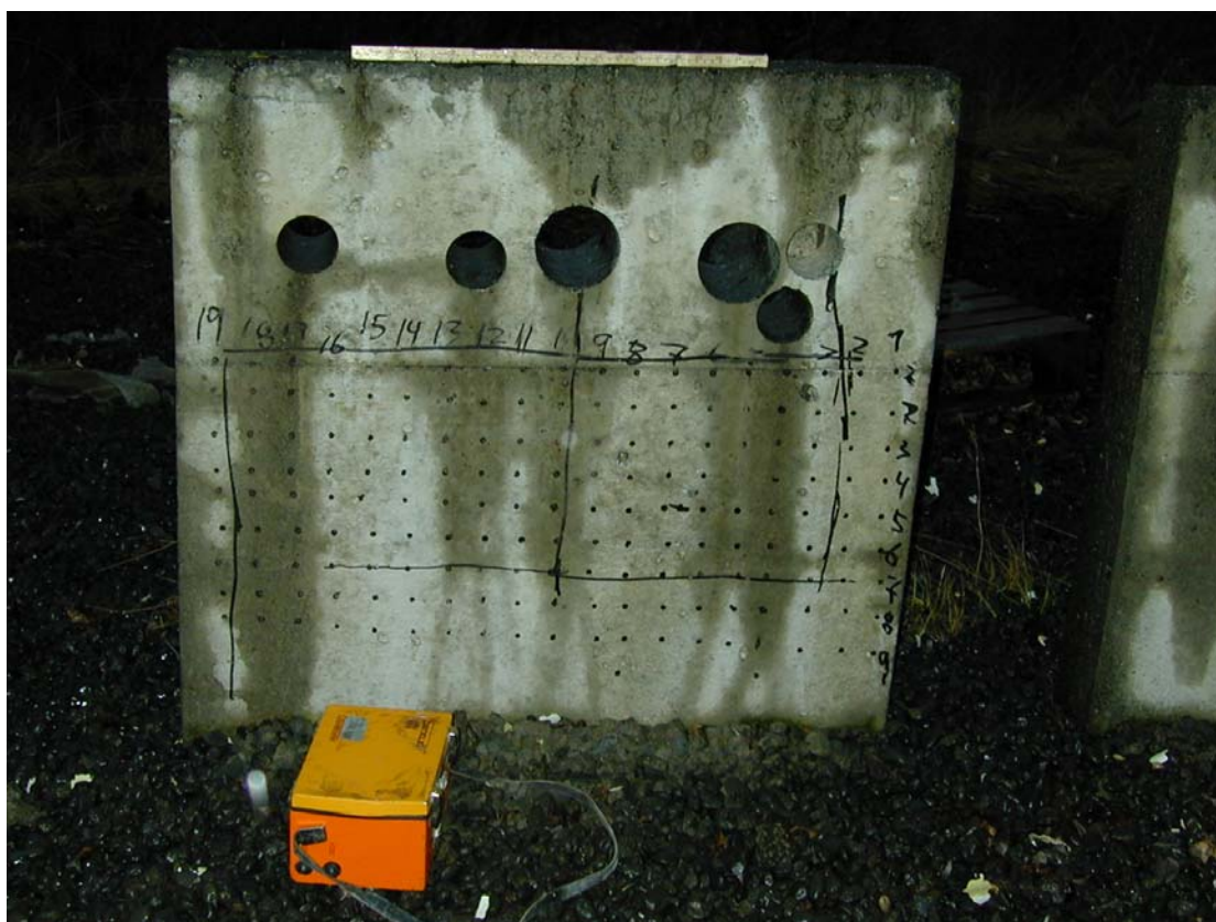
Mynd 29. Staðsetning mælipunkta og járnagrindar í vegg 1. Götin eru þar sem kjarnar hafa verið boraðir. Sjá má hluta af járnagrindinni í holunni lengst til hægri. Línur 1, 4 og 7 voru mældar með 5 cm millibili og byrjað var í hægri horninu uppi.
