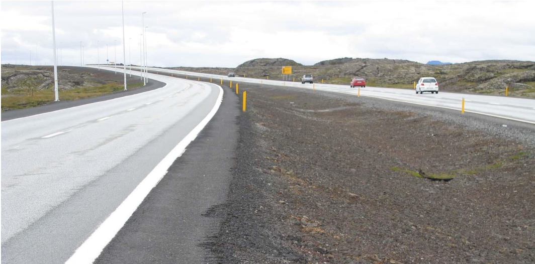
Mynd 35. Reykjanesbrautin við Hvassahraun. Horft í átt til Höfuðborgarsvæðisins.
