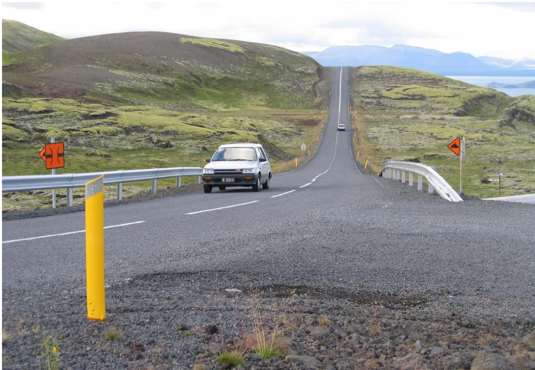
Mynd 28. Horft eftir Nesjavallavegi í átt að Þingvallavatni frá áningarstað ofan við Nesbúð.
