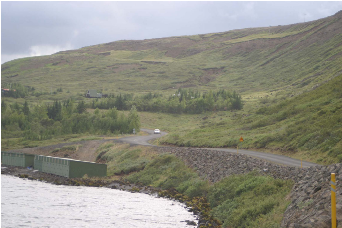
Mynd 22. Grafningsvegur efri við Nónbrekkur. Vegur á fyllingu.
