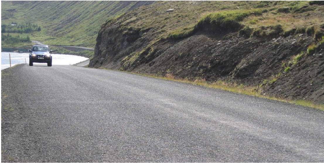
Mynd 21. Grafningsvegur efri í Nónbrekkum, þar liggur vegurinn í skeringum og berggrunnur og jarðvegur sjáanlegur.
