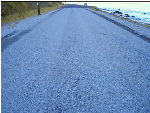
Mynd 24. Kafli H-4 Durasplitt með 11-16 mm steinefni. Myndin er tekin í átt að Hnífsdal (út eftir). Raki í könnnum klæðingar og e.t.v. á smáblettun hér og þar.
