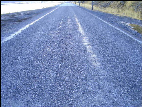
Mynd 22. Kafli H-4 Durasplitt með 11-16 mm steinefni. Myndin er tekin í átt að Ísafirði (inn eftir, í sömu átt og lagt var út). Lítur mjög vel út.
