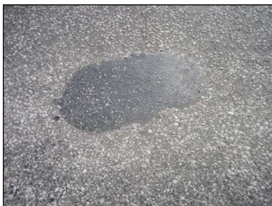
Mynd 3. Hér er smávægileg viðgerð, sem kemur út sem bikrík skella á gömlu klæðingunni
