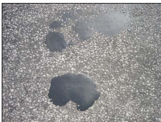
Mynd 4. Á þessari mynd eru sams konar viðgerðir og á mynd 3, þ.e.a.s. bikríkar skellur, þar sem allt gróft steinefni vantar. Það vekur spurningu um hvort þessir feitu blettir muni koma upp á yfirborð nýju klæðingarinnar (tilraunakaflanna) næsta sumar, þegar hitnar í veðri með hækkandi sól.
