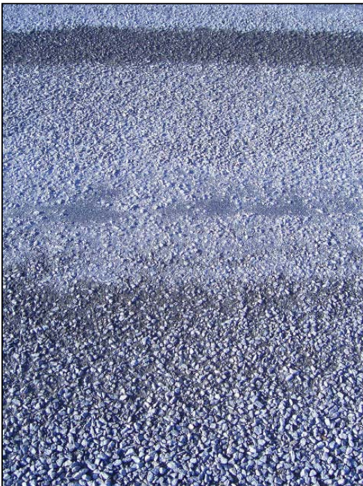
Mynd 14. Kafli H-1 Austmannsfall með 11-16 mm steinefni. Myndin er tekin þvert á kaflann um miðbik hans. Sjá má vott af strípaðri rák fyrir miðri mynd. E.t.v. orsakaðist hún að stíflaða spíssinum sem minnst er á í kaflanum hér að framan. Steinatap greinilegt þar sem spíss var stíflaður.
