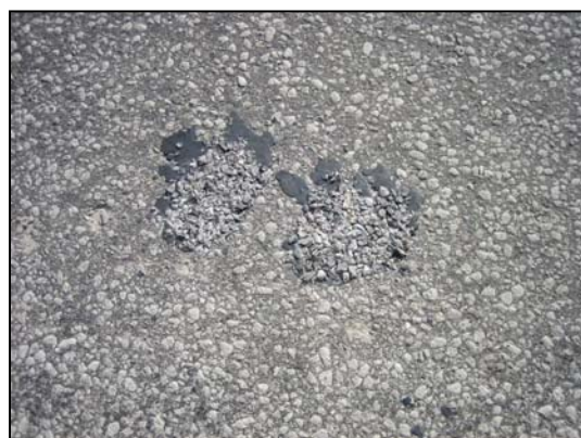
Mynd 6. Sama og á mynd 5, nema mun minni viðgerð, tvær litlar holur sem fyllt hefur verið í með biki og steinefni.
