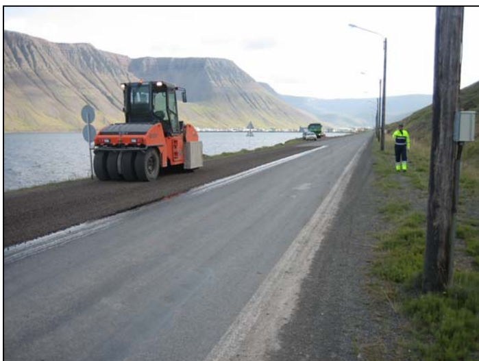
Mynd 11. Hér hafur verið lagt á fyrri akreinina og valtari fylgir á eftir.
