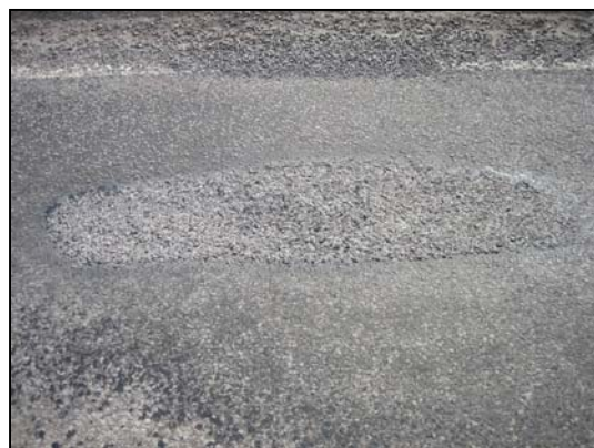
Mynd 5. Hér situr eftir steinefni í viðgerð, en með bikríkum kraga í kring.
