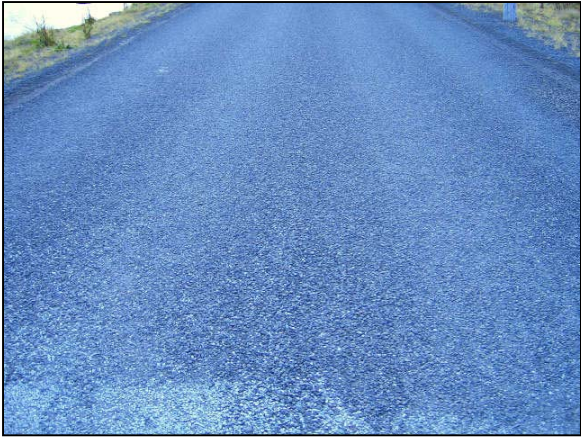
Mynd 28. Kafli H-6 Hálfðánarvatn með 11-16 mm steinefni. Myndin er tekin í átt að Ísafirði (inn eftir, í sömu átt og lagt var út). Lítur vel út.
