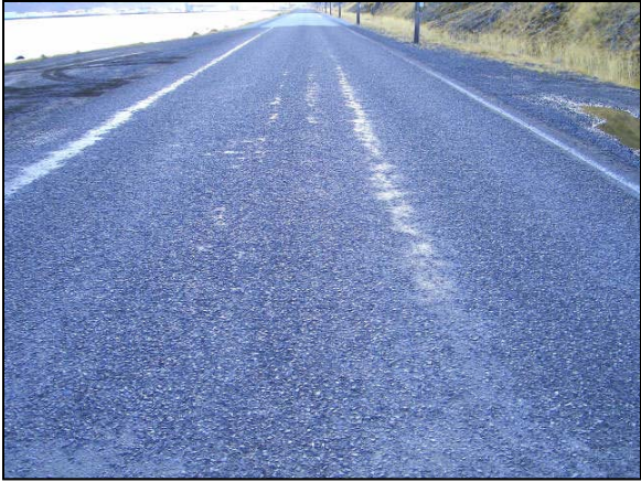
Mynd 25. Kafli H-5 Durasplitt með 8-11 mm steinefni. Myndin er tekin í átt að Ísafirði (inn eftir, í sömu átt og lagt var út). Lítur mjög vel út.
