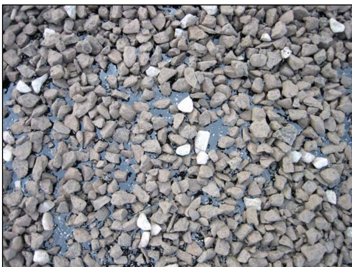
Mynd 12. Séð ofan í ný-útlagða klæðingu. Bindiefnið sést vel í gegn um steinefnakápuna eins og vera ber.
