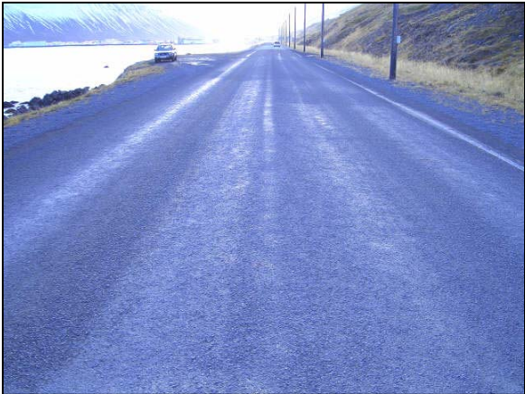
Mynd 16. Kafli H-2 Austmannsfall með 8-11 mm steinefni. Myndin er tekin í átt að Ísafirði (inn eftir, í sömu átt og lagt var út). Lítur vel út í heildina, en rák eftir spíss greinileg.
