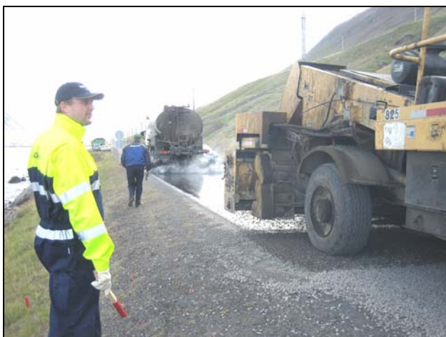
Mynd 10. Bindiefnisdreifari sprautar bindiefni og malar-dreifari fylgir á eftir. Kaflaskil sjást greinilega.
