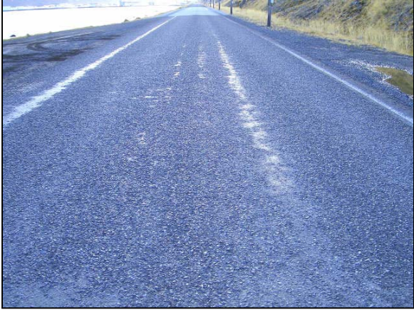
Mynd 19. Kafli H-3 Kleifabjörg með 11-16 mm steinefni. Myndin er tekin í átt að Ísafirði (inn eftir, í sömu átt og lagt var út). Rákin á hægri akrein er steinlos vegna stíflaðs spíss.
