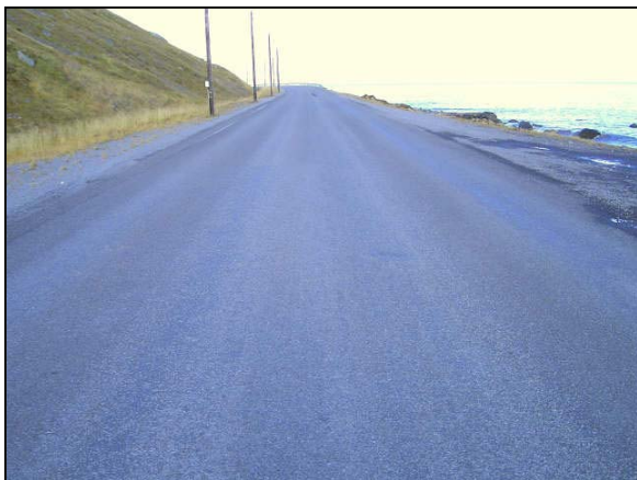
Mynd 18. Kafli H-2 Austmannsfall með 8-11 mm steinefni. Myndin er tekin í átt að Hnífsdal (út eftir). Kaflinn virðist í nokkuð góðu lagi og yfirborðið nokkuð jafnt og þétt. Ekki er greinilegt á þessari mynd að spíss hafi verið stíflaður.
