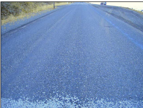
Mynd 21. Kafli H-3 Kleifabjörg með 11-16 mm steinefni. Myndin er tekin í átt að Hnífsdal (út eftir). Rák vegna steintaps er hægra megin mynd, sjávarmegin.
