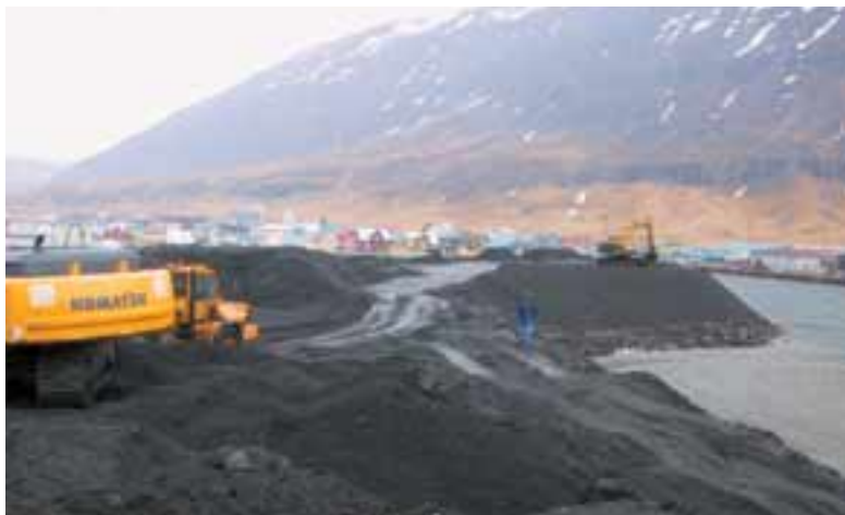
Frá Seyðisfirði. Unnið að því að fergja svæðið við nýja ferjulægið. Efni er hlaðið upp 4 m hærra en væntanlegt bryggjugólf. Ljósmynd Kristján Helgason.
