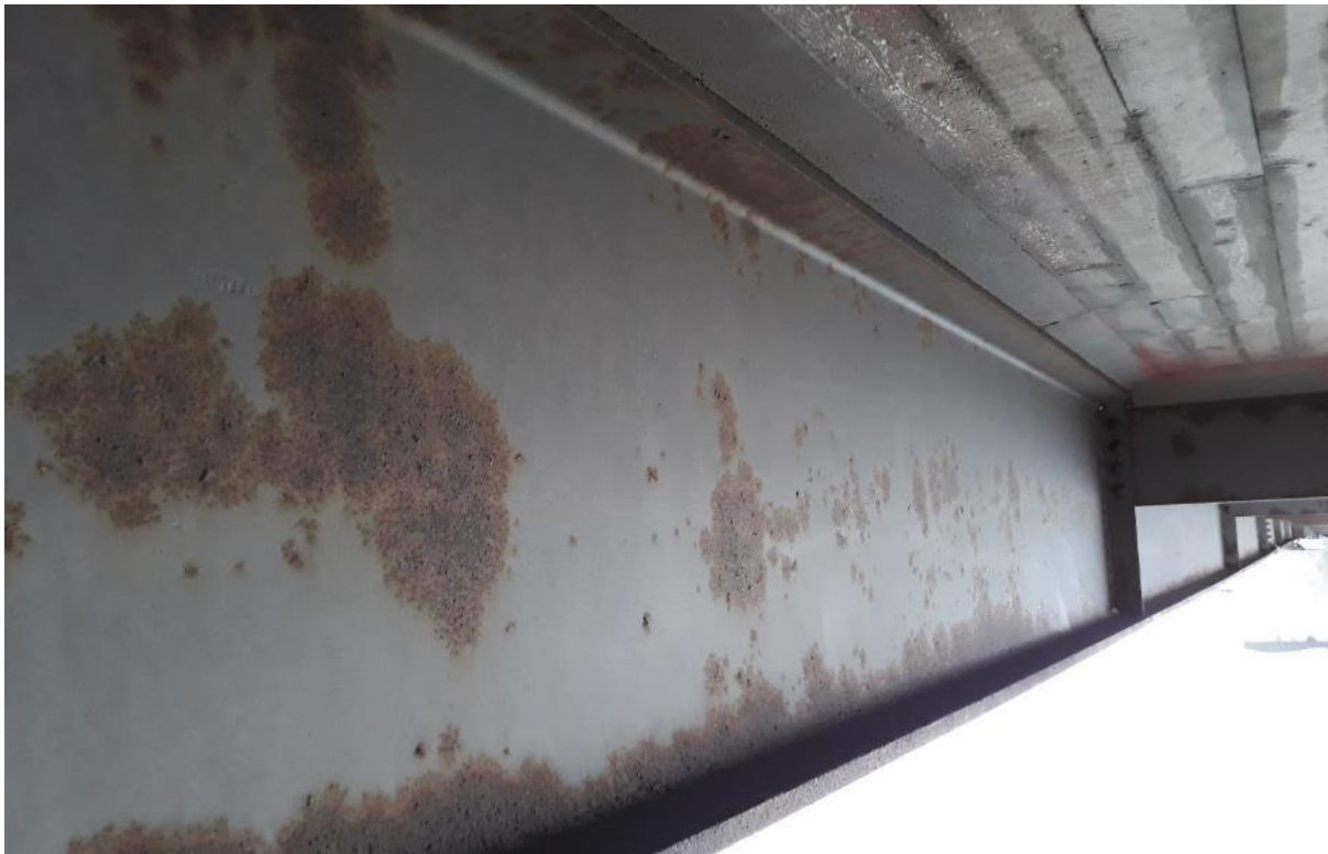
Mynd 11. Hliðar stálbitanna sem sneru inn í brúna voru áberandi meira ryðgaðar en ytri hliðar bitanna. Ljósmynd Sjótækni ehf
