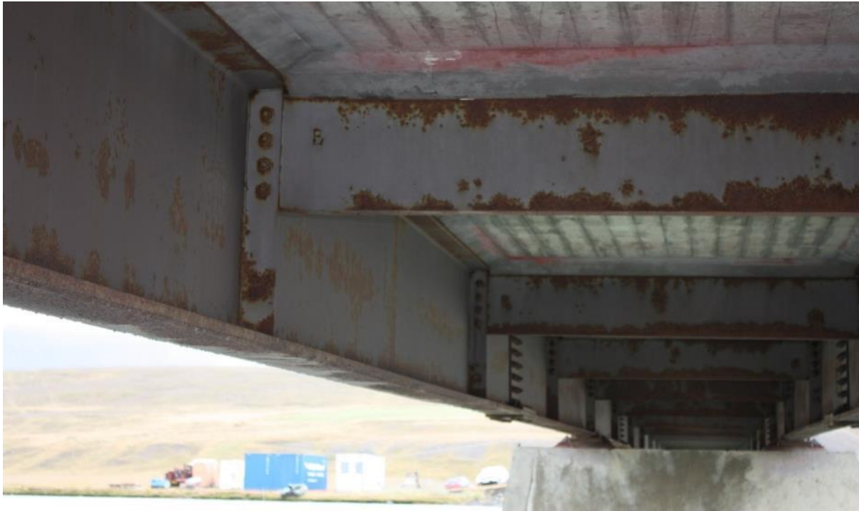
Mynd 7. Stálbitarnir fyrir sandblástur. Ljósmynd Sjótækni ehf.
