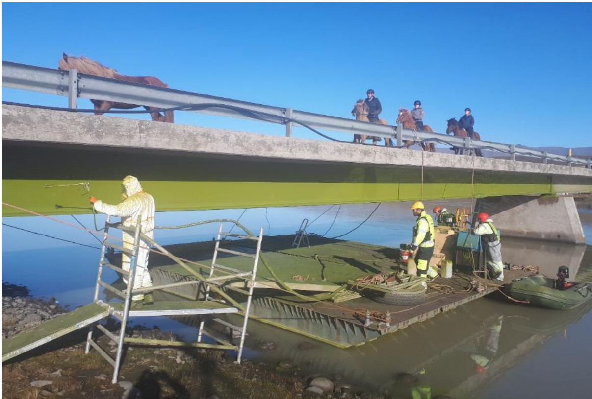
Mynd 3. Unnið var við sandblástur og úðun á fljótandi vinnuþöllum sem færðir voru til undir brúnni eftir því sem verkinu miðaði. Ljósmynd Sjótaekni ehf.
