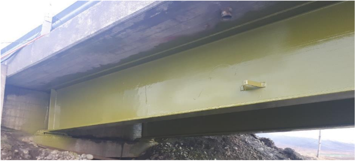
Mynd 9. Stálbitinn eftir úðun Humidur, aðeins þarf að úða einu sinni. Ljósmynd Sjótækni ehf.
