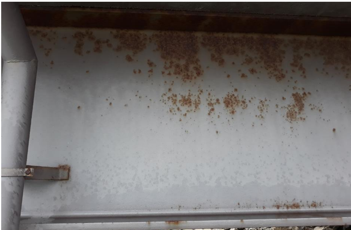
Mynd 12. Ytri hlið stálbita, þessi hlið snýr í norður. Ljósmynd Sjótækni ehf.
