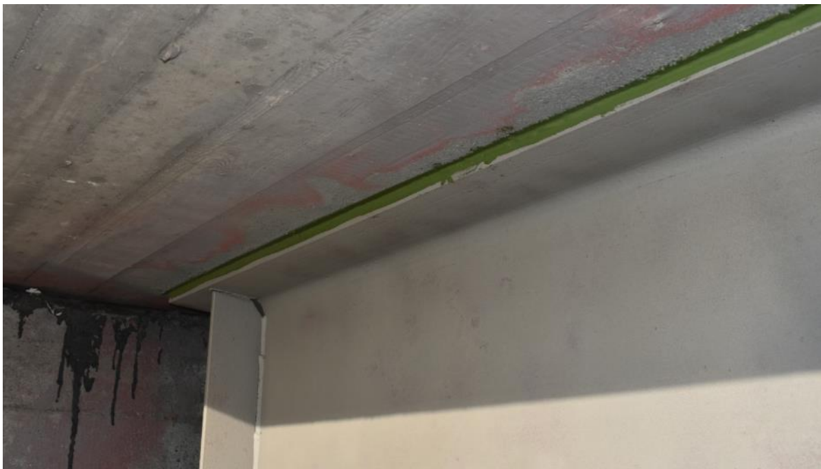
Mynd 15. Búið er að bera Humidur í samskeyti steypu og stáls til að hindra veðrun. Ljósmynd Sjótækni ehf.
