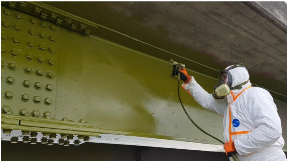
Mynd 5. Úðun með yfirborðsefninu Humidur á stálbita með hefðbundinni málningarsprautu. Málarninn er í heilgalla og með andlitsgrímu til að vernda öndunarfæri og húð fyrir finum úða. Ljósmynd Sjótækni ehf
