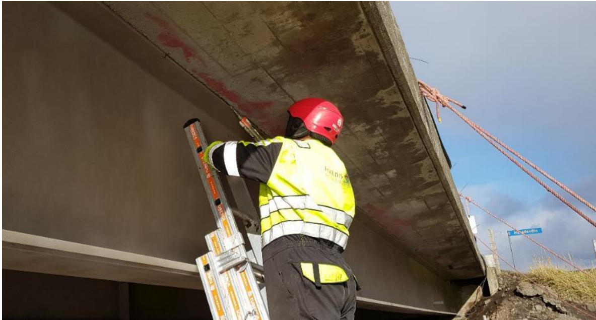
Mynd 14. Humidur er borið með kíttisprautu á öll samskeyti stáls og steypu og við bolta og samskeyti til að loka fyrir aðgengi veðrunar að stálinu. Ljósmynd Sjótækni ehf.
