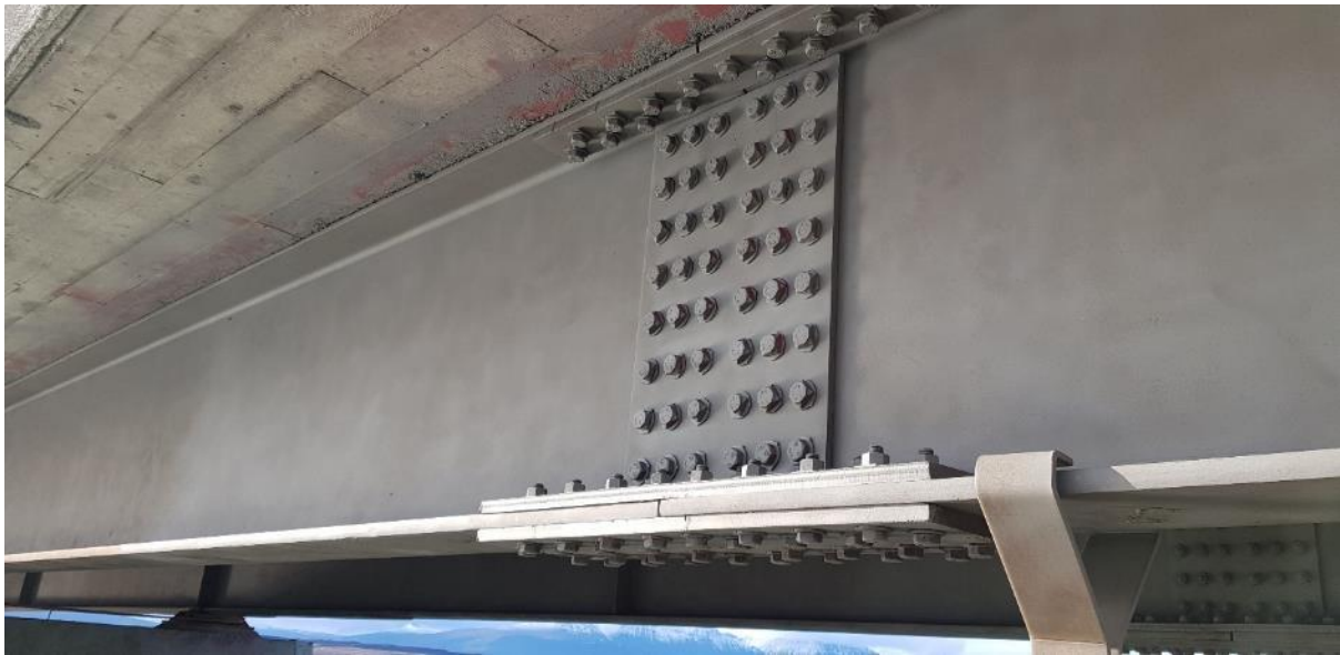
Mynd 8. Stálbitinn og samsetning bita eftir sandblástur. Ljósmynd Sjótækni ehf.
