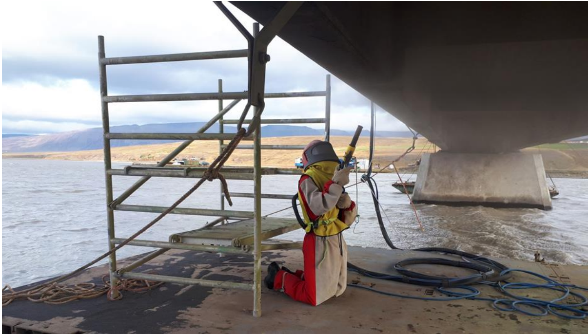
Mynd 13. Unnið við sandblástur undir brúnni yfir eystri ós Héraðsvatna í Skagafirði á fljóttandi vinnuþöllum sem færðir voru til eftir því sem verkinu miðaði. Ljósmynd Sjótækni ehf.
