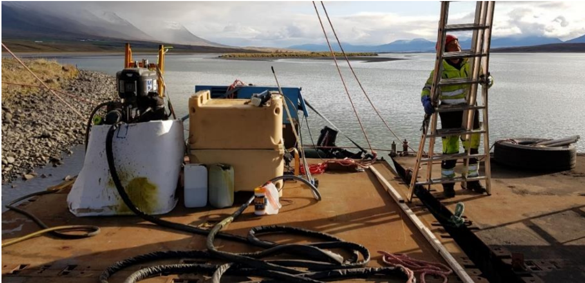
Mynd 4. Málningardæla og kór sem notuð voru til að halda hita á yfirborðsefninu Humidur við úðun þess, unnið var á fljótandi vinnuþöllum undir brúnni til að auðvelda aðkomu að stálbitunum. Ljósmynd Sjótækni ehf.
