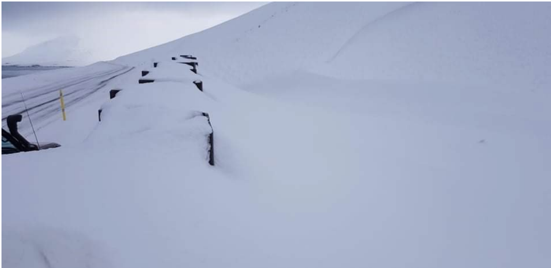
Mynd 2 sýnir snjóflóðaskáp við farveg nr. 37 fullan af snjó í lok febrúar 2020. Ljós. MogT.
