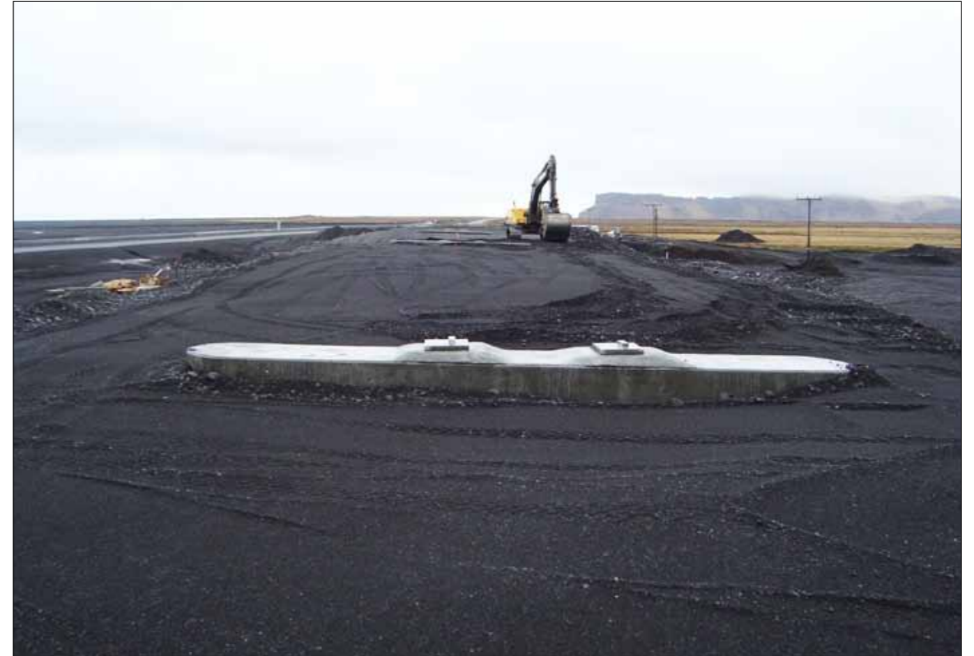
Brúargerð yfir Múlavísl á Mýrdalssandi. Til að spara verkpalla undir brúna var fyllt upp á milli stöpla með mól af staðnum og hún þjöppuð vel. Síðan eru steyptar rennur ofan á fyllinguna langsam á milli stöpla (sjá neðri mynd) og brúargólfíð byggt ofan á þær. Þegar brúin er tilbúin verður fyllingin fjarlægð ásamt rennunum og undirslattinum. Verktaki Eykt ehf.
