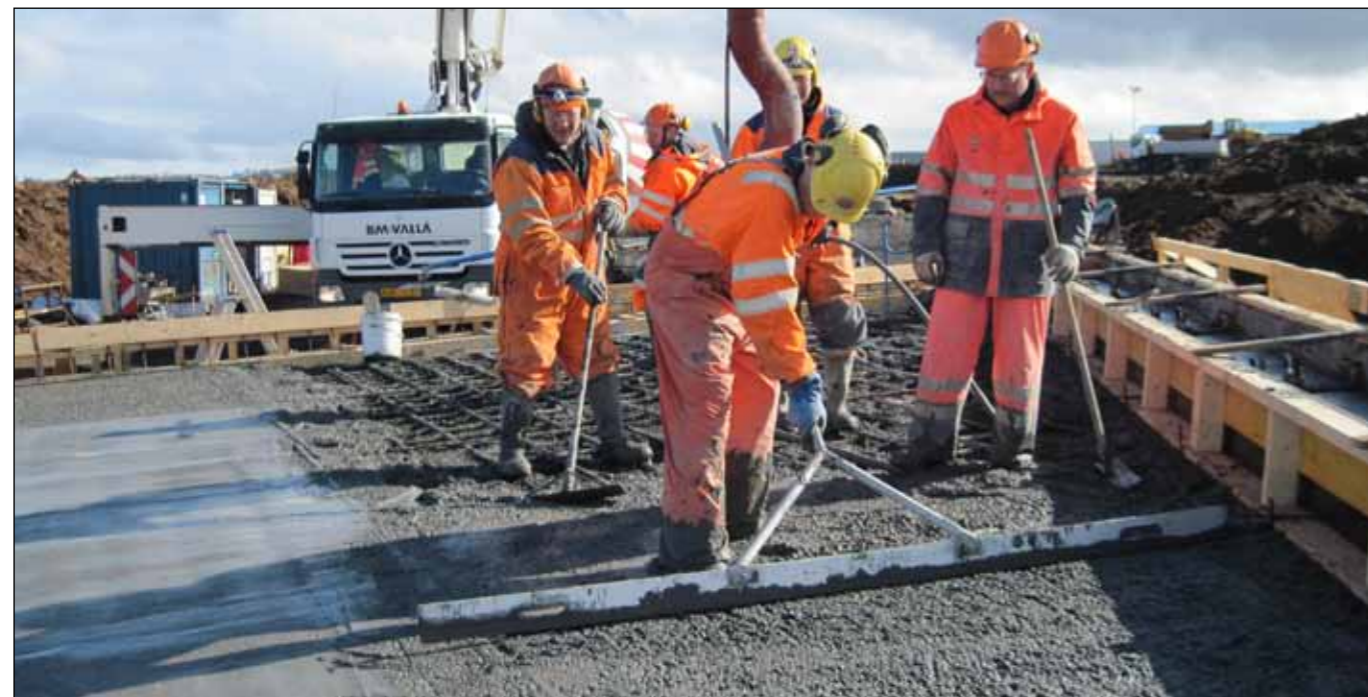
Álftanesvegur, plata steipt á undirgöng við Garðaholt 25. mars. Verktaki ÍAV.
