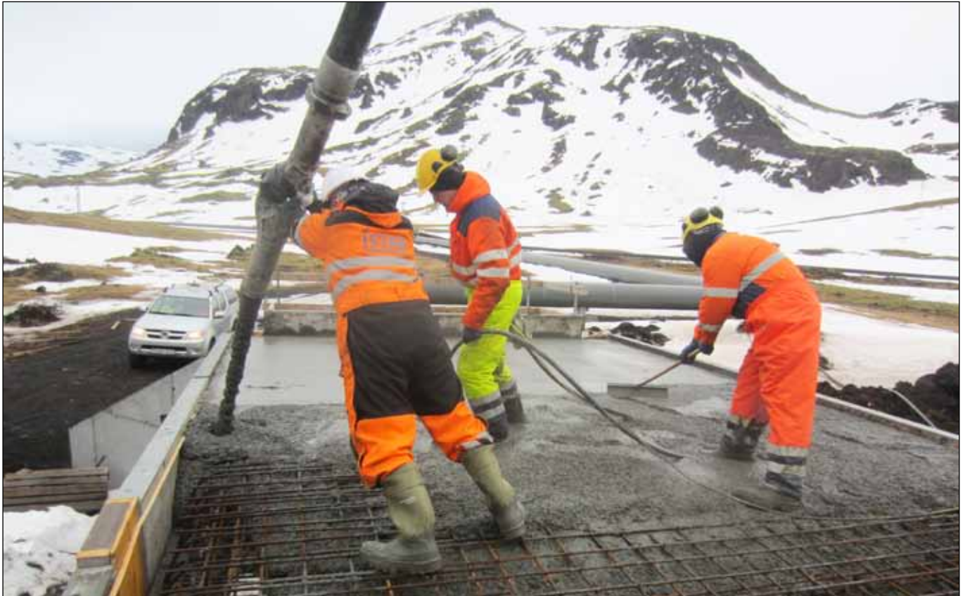
Steypa á stokki sem gerður er fyrir gufupípur Nesjavallavirkjunar undir nýjan Skíðaskálaveg frá Nesjavallavegi að skíðaskálanum í Hveradölum. Gerð hans er innifalin í brekkun vegar yfir Hellisheiði og Kamba. Verktaki Ístak hf.
