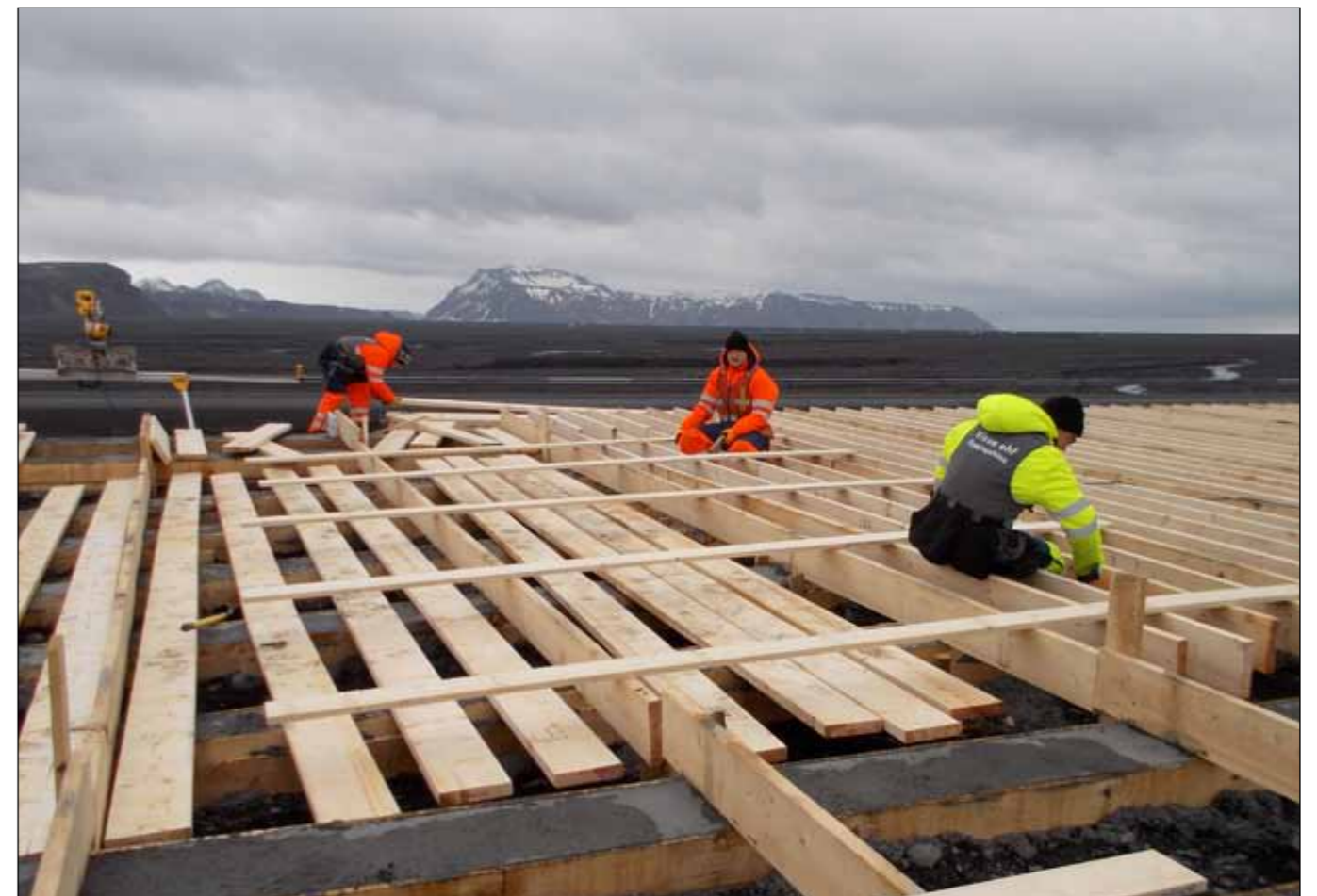
Brúargerð yfir Múlavísl á Mýrdalssandi. Til að spara verkpalla undir brúna var fyllt upp á milli stöpla með mól af staðnum og hún þjöppuð vel. Síðan eru steyptar rennur ofan á fyllinguna langsam á milli stöpla (sjá neðri mynd) og brúargólfíð byggt ofan á þær. Þegar brúin er tilbúin verður fyllingin fjarlægð ásamt rennunum og undirslattinum. Verktaki Eykt ehf.
