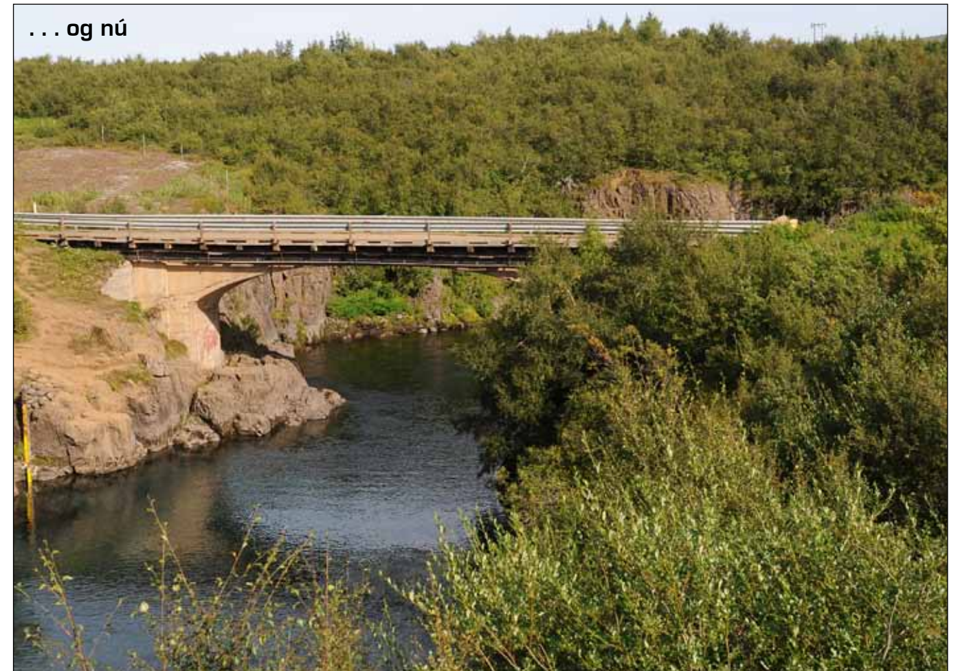
Brúin á Eyvindará var breikkuð 1955 og timburgólf sett á hana 1958. Þannig var hún í notkun til ársins 2001 en þá var ný brú byggð á Eyvindará aðeins neðar í ánni. Gamla brúin þjónar nú skemmtilegri gönguleið.
