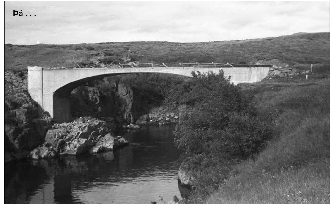
Brú á Eyvindará á Seyðisfjarðarvegi (93) við Egilsstaði, byggð 1919. Áður var trésperrubrú á ánni, líklega byggð 1879. Myndin er tekin árið 1947. Væntanlega hefur brúin verið full mjó fyrir herflutninga stríðsáranna og handriðið því lagt niður heldur ósnyrtilega.
