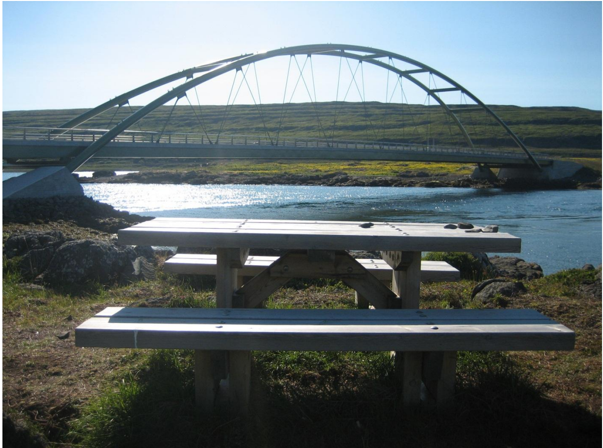
Mynd 1. Vörðuna, viðurkenningu Vegagerðinnar fyrir mannvirki 2008-2010, hlaut verkefnið Djúpvegur, Reykjanes-Hörtná. Hluti af þeim vegi er þverun Mjóafjarðar með 130 m langri stálbogabru (Helga Aðalgeirsdóttir).
