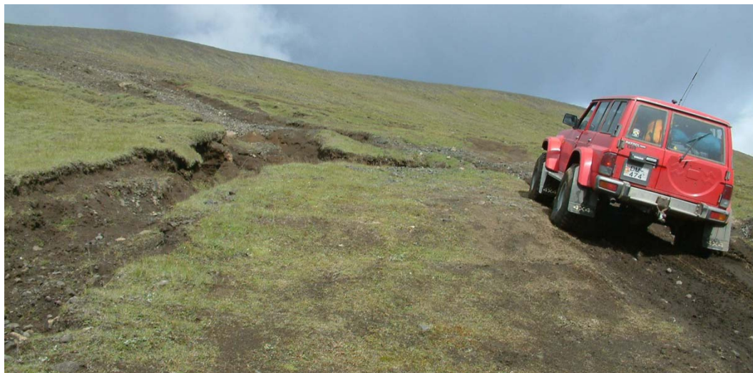
Mynd 3.1: Rof-úrrennslí. Í öllum landshlutum eru algengustu skemmdir á slóðum vegna leysinga- og regnvatns. Úrrennslí getur rífið með sér allt fínefni úr slóðinni og skilur eftir djúp og stórgrýtt rof og skurði í akstursleiðina.
