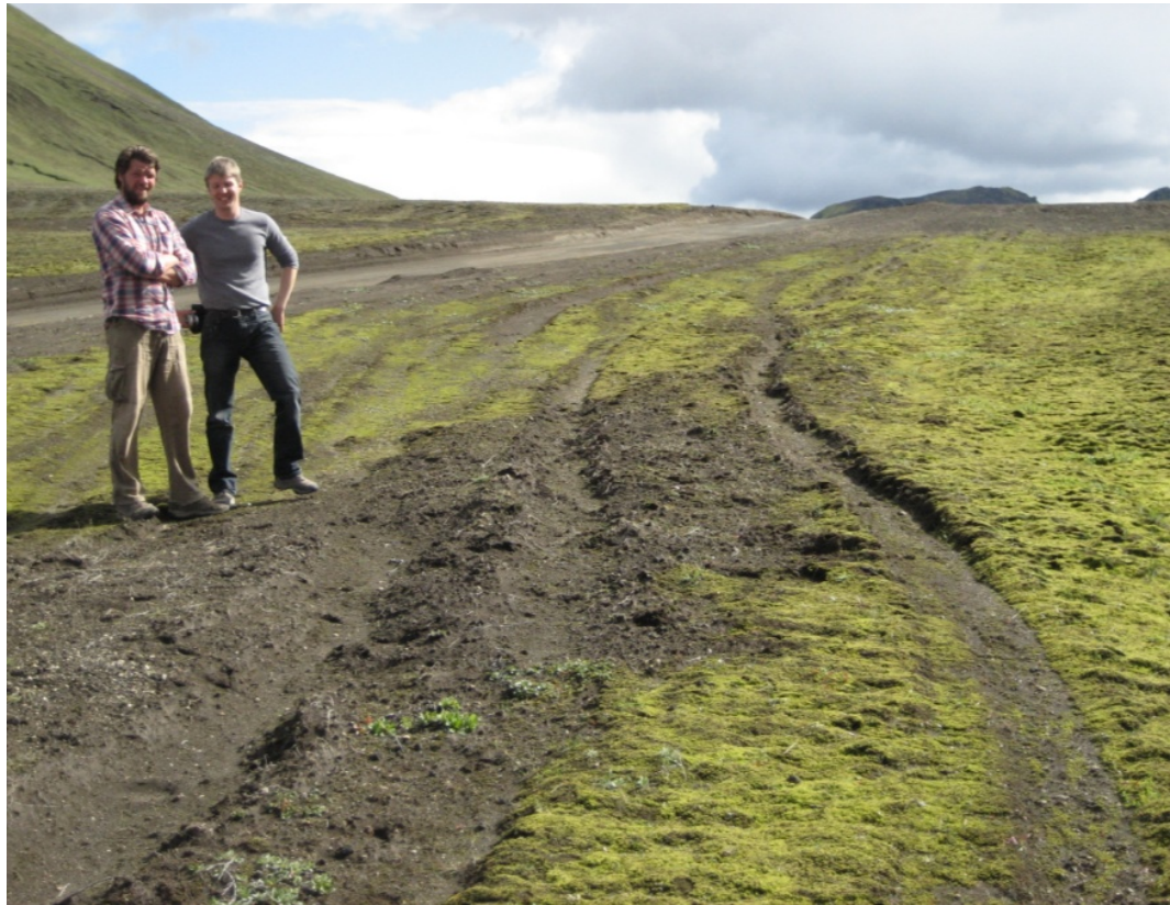
Mynd 3.13: Skemmdir sem þarf að laga. Jafnframt þarf að loka vegjöðrum þannig að síður sé keyrt út í mosabekjuna.
