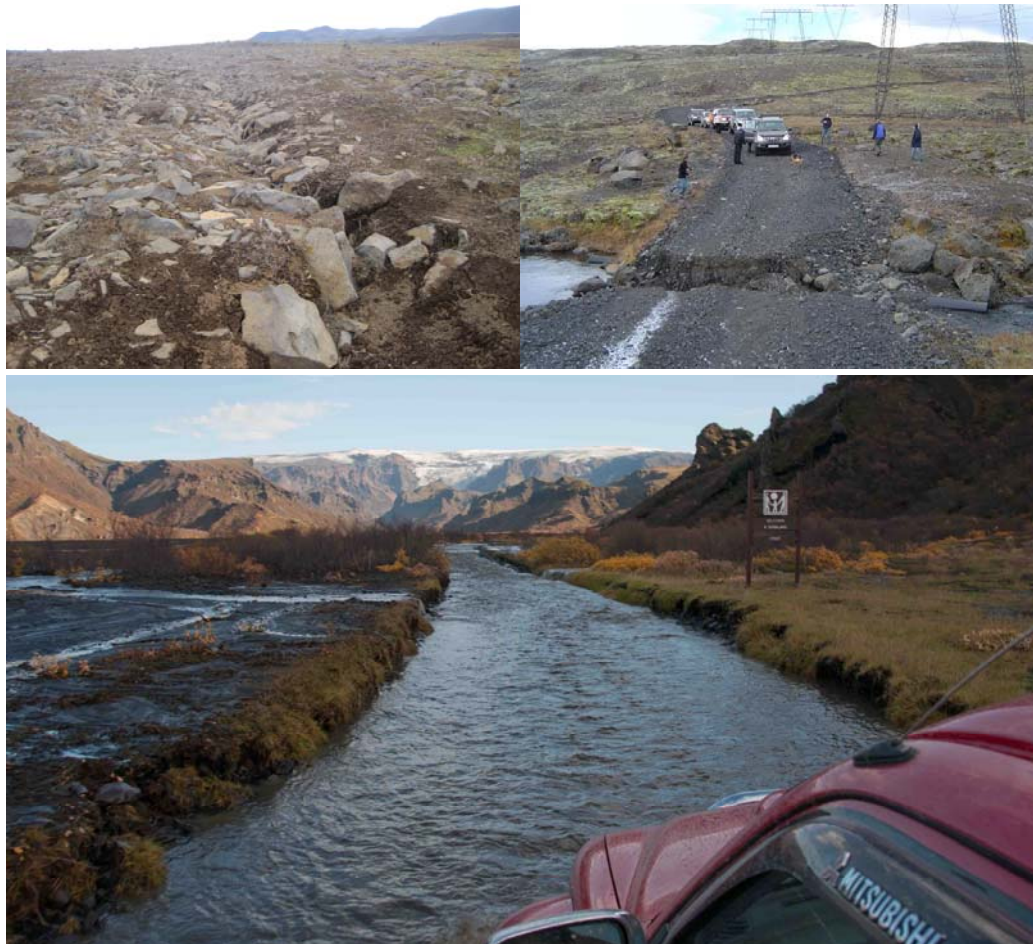
Mynd 5.6: Gera þarf við skemmdir til að koma í veg fyrir skemmdir eða hliðarspor. Í sumum tilfellum getur verið nauðsynlegt að huga að ræsislausn.
