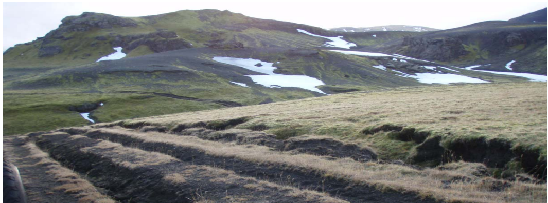
Mynd 3.5: Bílaslóð í grónu landi. Jarðvegurinn treðst undir hjólunum þótt þau risti grasrótina ekki í sundur. Hjólförin móta farveg fyrir afrennsli regn- og leysingavatns. Rigningavatn sem annars rennur rólega niður brekkurnar safnast í hjólförin, rennur mun hraðar og grefur slóðina. Það getur að lokum rífið svörðinn og skilið eftir ljót sár sem opna leið fyrir uppblæstri.
