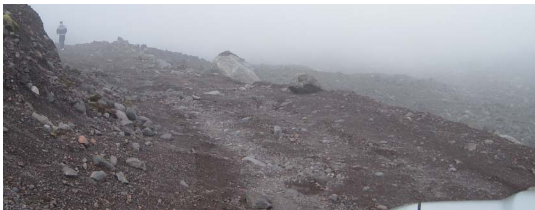
Mynd 3.7: Torfarið yfirborð slóða. Yfirborð slóða getur verið mjög misjafnt allt eftir landslagsgerð og ofaníbúðri slóðarinnar. Torfarin slóð getur verið ójöfn, grýtt, blaut, torfær vegna sandsöfnunar eða leirdrullu. Vúppsur, húppur eða þvottabretti er það kallað þegar sandöldur myndast í slóðinni vegna samþjöppunar í einsleitu yfirborði.
