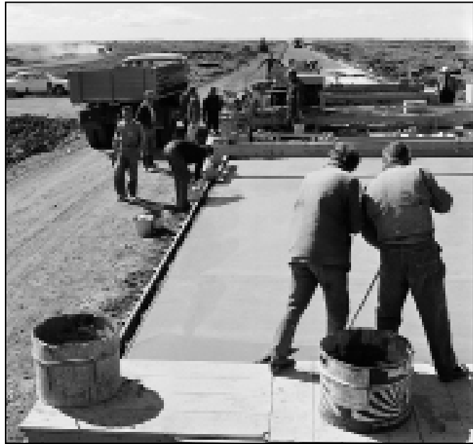
Keflavíkurvegurinn var steypur á árunum 1960-1965
