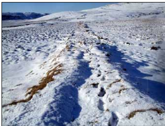
Vegbrú yfir mýri í Seljadal
