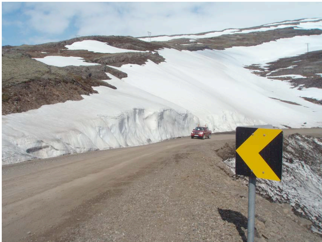
Mynd 3: Myndarlegur snjóskafli í Háabrekku 21. maí 2008. Einn þriggja helstu farartálma á núverandi vegi þar sem snjó skefur þvert á veglínu.
