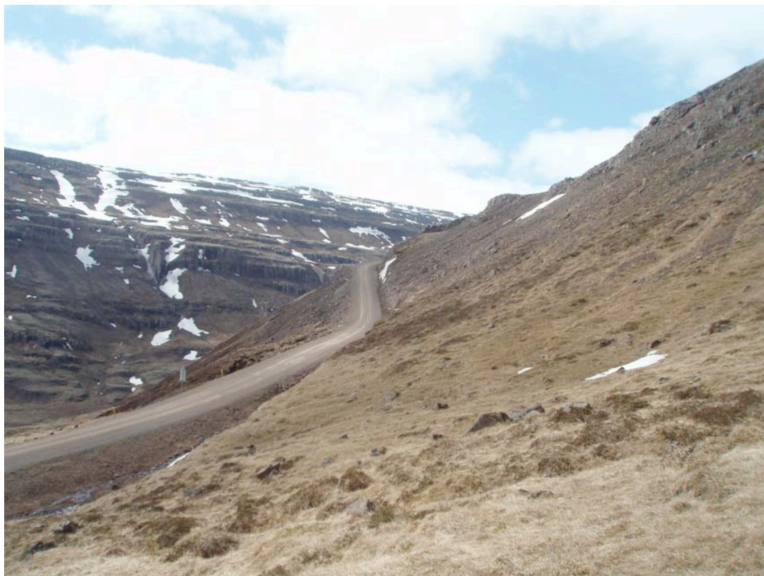
Mynd 11. Horft til vesturs að stað [16800] í beygjuni. Fyrirhugað vegstæði norðan núverand vegar og nærri samsíða honum.
